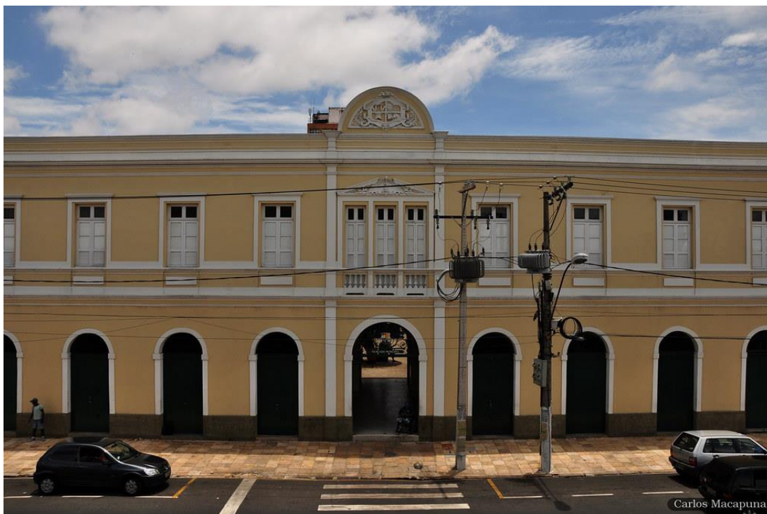
Imagem 6 – Mercado de Carne Francisco Bolonha – área externa
