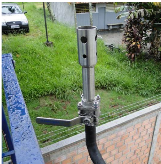
Figura 9 – Válvula de liberação do gás para o queimador da chama piloto
