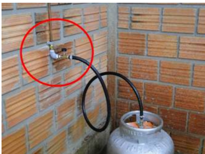
Figura 15 – Registro geral do botijão de GLP
