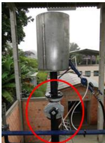
Figura 10 – Válvula do “Flare”
