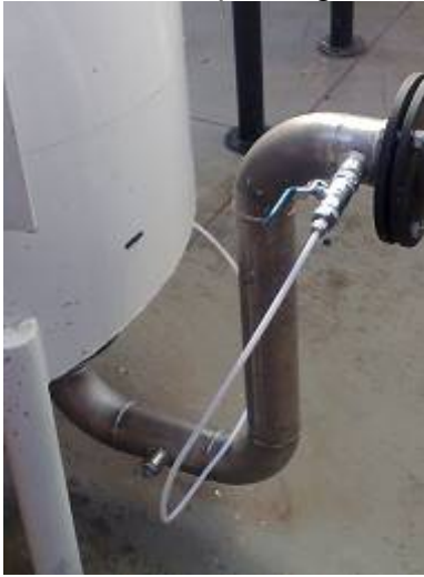
Figura 18 – Ponto de coleta de gás após o gasômetro
