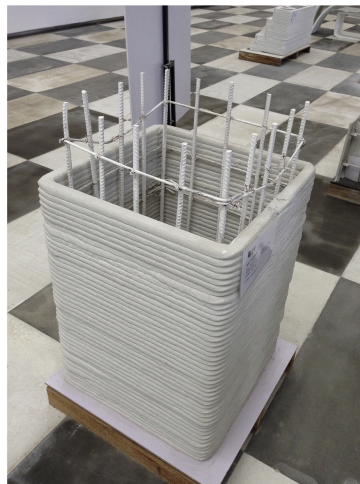
Figura 6 – Fôrma utilizada para elemento estrutural sendo impresso pela empresa WinSun
