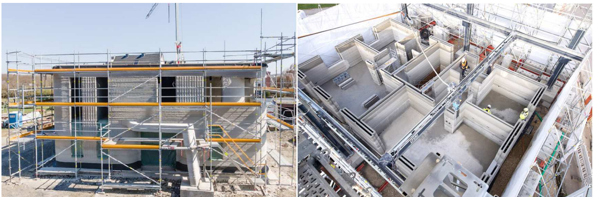
Figura 8 – Maior edifício residencial da Europa sendo construído com impressão 3D
