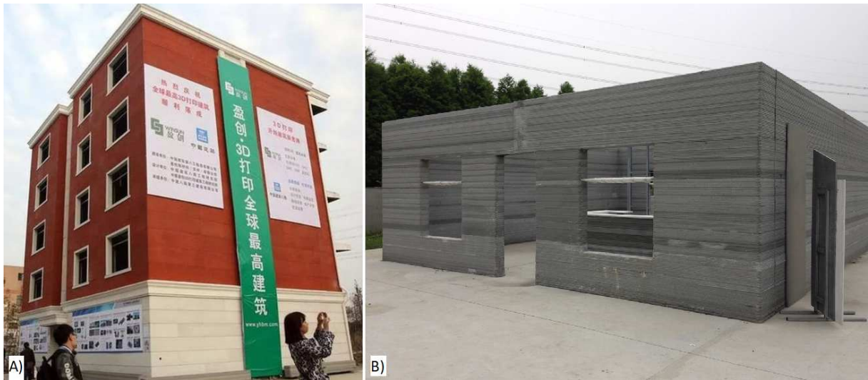
Figura 5 – Obras impressas pela empresa WinSun - Edifício A); Sobrado em andamento B).
