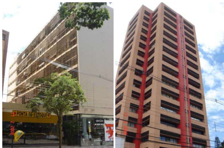
Figura 12- Fotografias de edifícios com brises e com recuo de esquadria.
