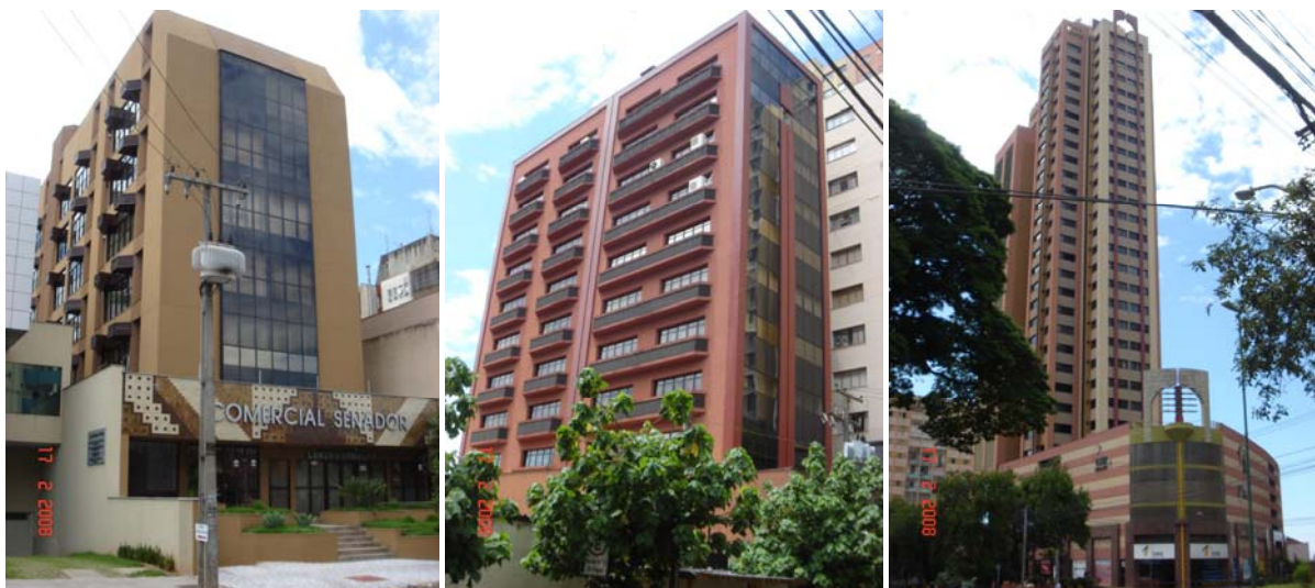
Figura 5- Fotografia de edifícios de 5, 9 e 25 pavimentos-tipo.
