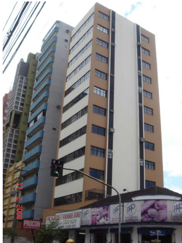
Figura 10- Fotografia de edifício de WWR de 21 a 40%.
