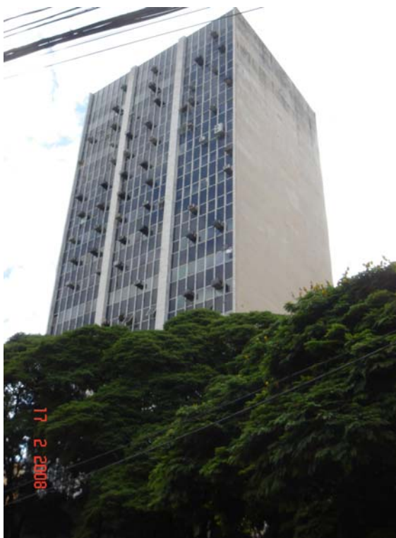
Figura 13- Fotografia de edifício com empena cega.
