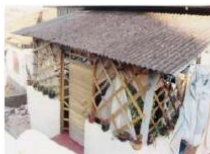
Construção de pequenas rampas: adequação que indica a utilização do local
