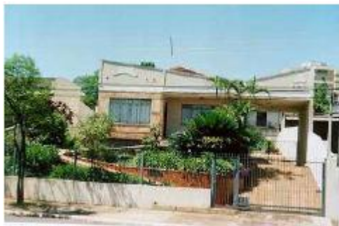
Casa com telhado “borboleta”, escadaria trabalhada de acesso e jardim frontal
