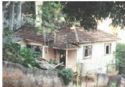
Casa dos fundos ao lado do canteiro
