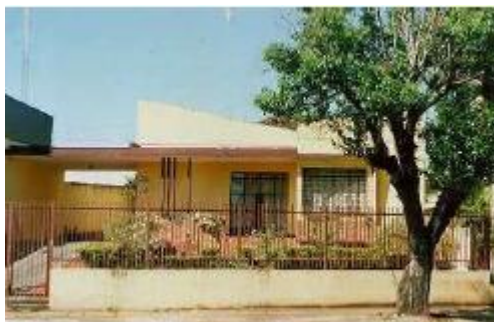
Casa com metade da platibanda inclinada e metade reta (misto dos 2 exemplos anteriores)
