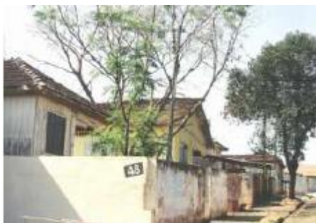
Conjunto de casas de madeira Fonte Lamounier (2006)
