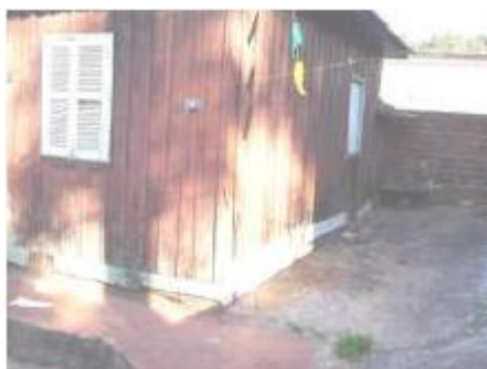
Residência sem intervenções
