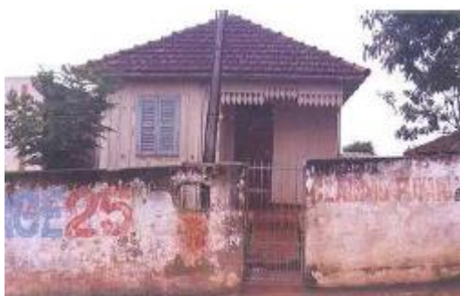
Casa de madeira com lambrequins na varanda
