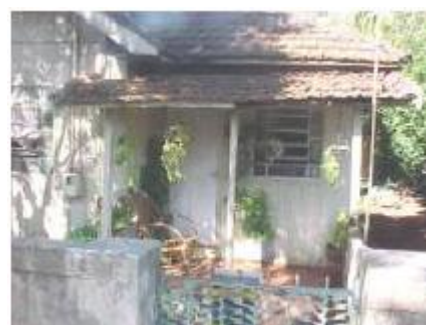
Varanda: simbolismo e gradação entre público e privado
