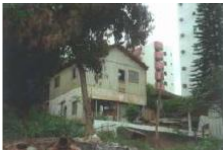
Casa de madeira com piso inferior em alvenaria: adaptação à forte declividade do terreno
