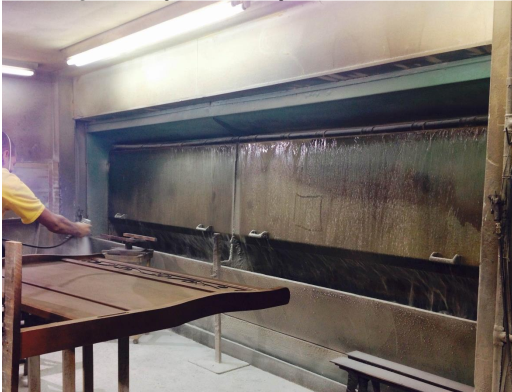
Figura 2 – Imagem da cabine de pintura em funcionamento.
