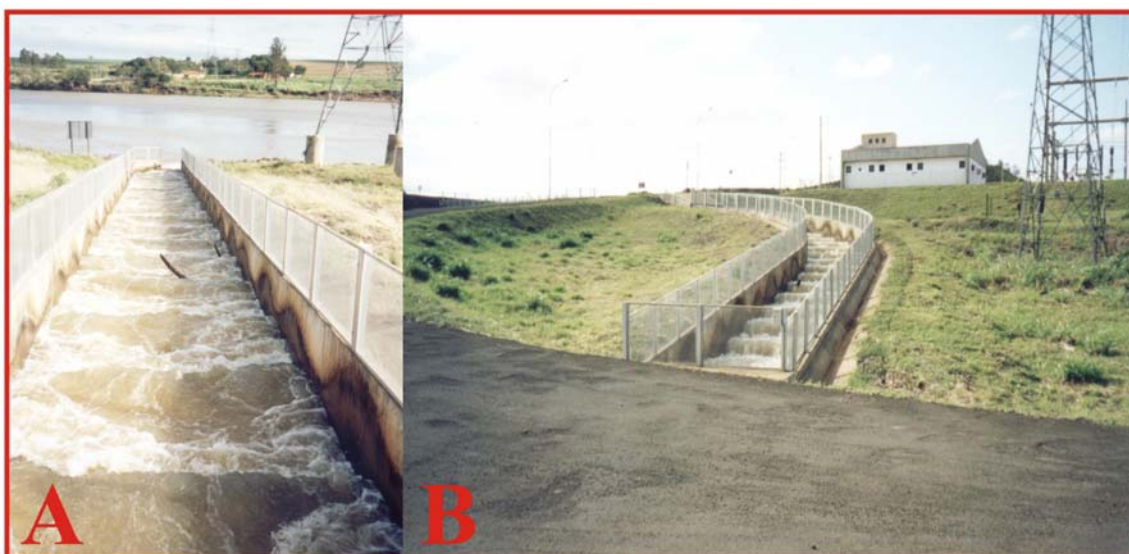
Figura 4 – Escada de transposição de peixes da UHE Canoas II. A) porção inicial da escada, a jusante e B) porção média e final da escada.
