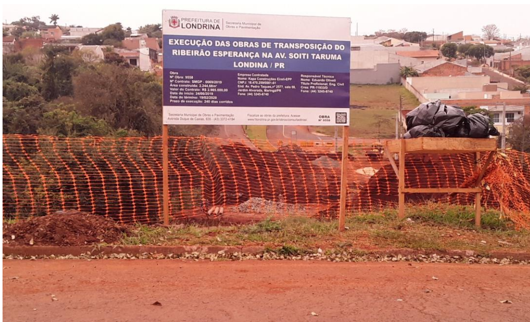
Figura 26 - Obras de Transposição do Ribeirão Esperança na Av. Soiti Tarumã
