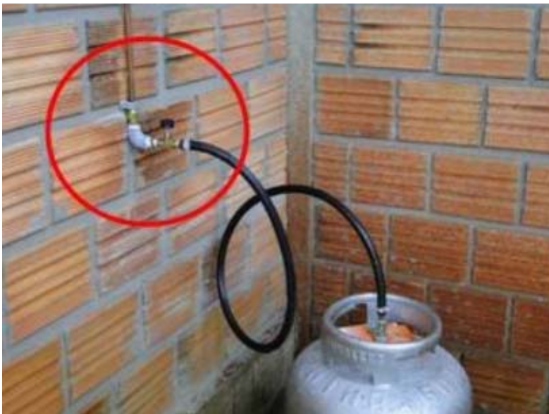
Figura 15 – Registro geral do botijão de GLP
