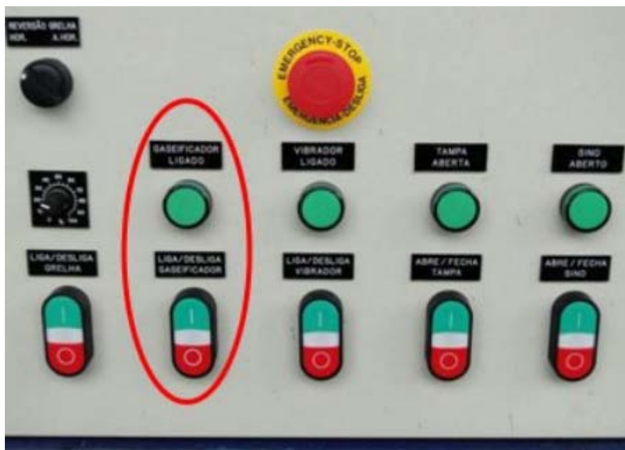
Figura 5 – Botoneira “Liga/Desliga Gaseificador” - tem a função de ligar/desligar o soprador de ar
