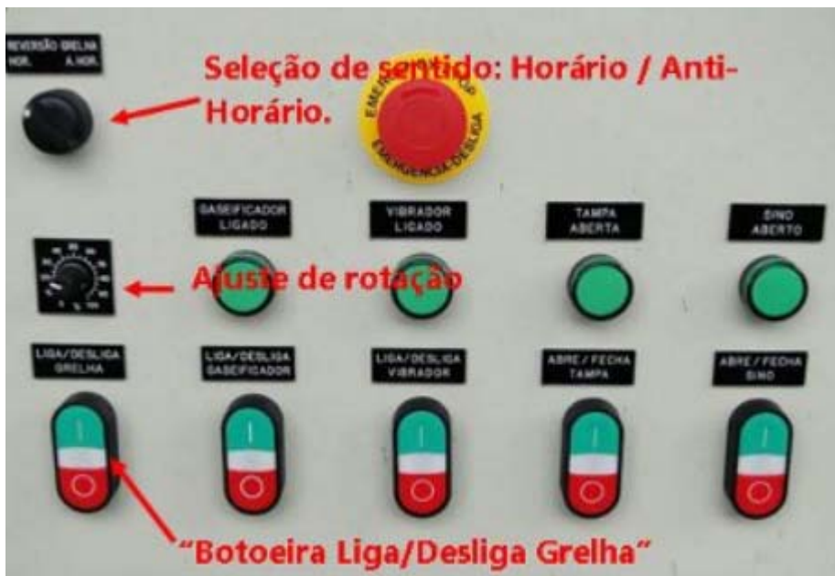
Figura 27 – Acionamento e ajuste de rotação da grelha
