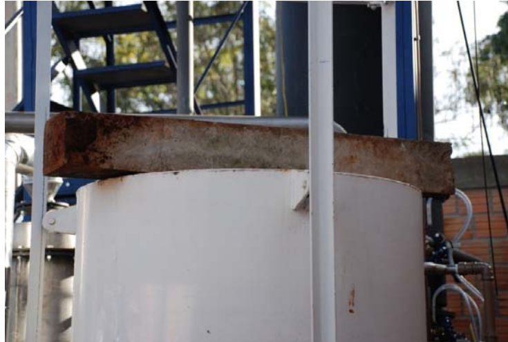
Figura 42 – Gasômetro com barra de concreto
