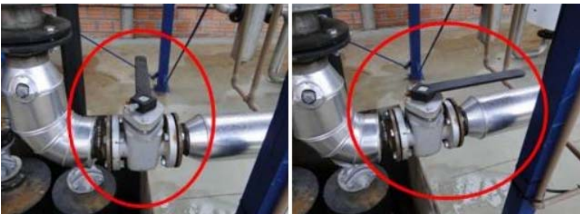
Figuras 7 e 8 –Válvulas de liberação do gás (na posição fechada e aberta respectivamente) para o gasômetro e posterior uso
