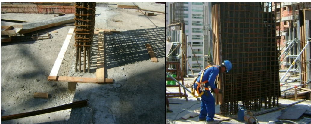
Figura 27 – Posicionamento formas dos pilares
