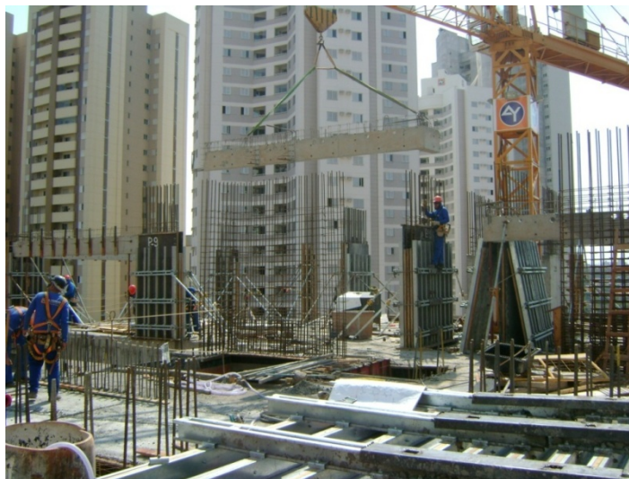
Figura 67 – Transporte das pré-vigas
