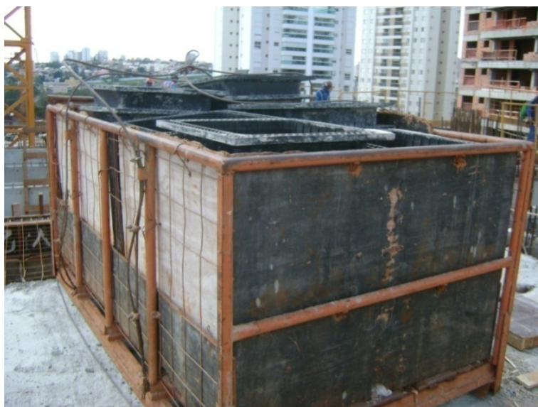
Figura 69 – Caixa metálica utilizada no transporte de cubetas
