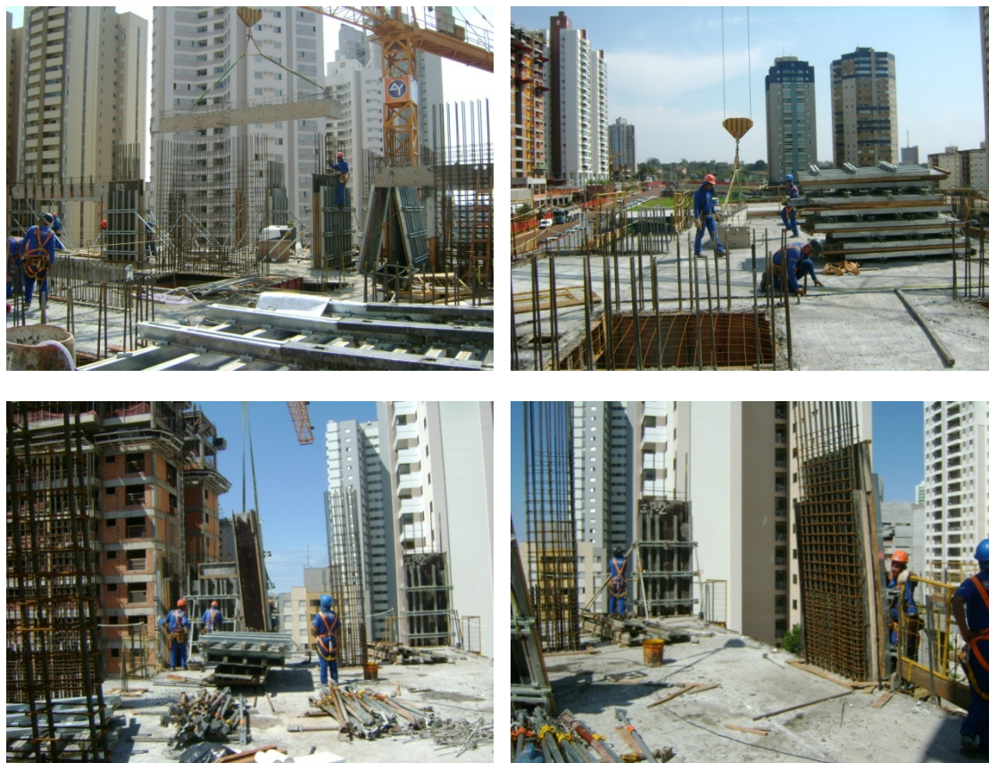
Figura 79 – Situação de sobrecarga da grua
