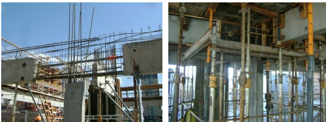
Figura 28 – Montagem de formas in loco
