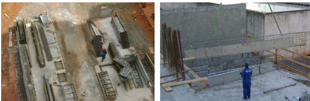
Figura 19 – Estoque de pré-vigas
