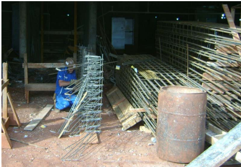
Figura 20 – Estoque de armaduras
