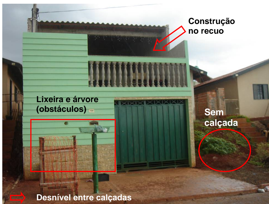
Figura (exemplo 20) – Rua 15 com obstáculos na calçada e quintal
