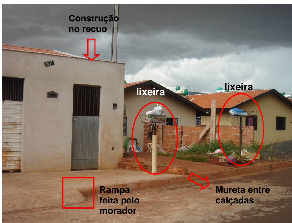
Figura (exemplo 18) – Rua 17 com obstáculos na calçada e quintal
