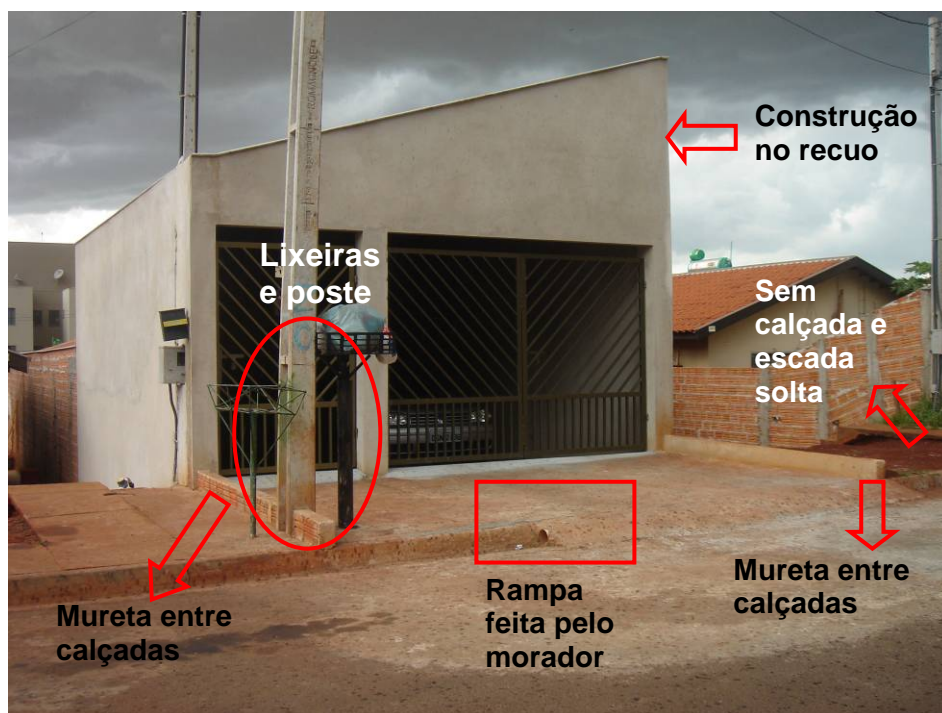
Figura (exemplo 19) – Rua 12 com obstáculos na calçada e quintal
