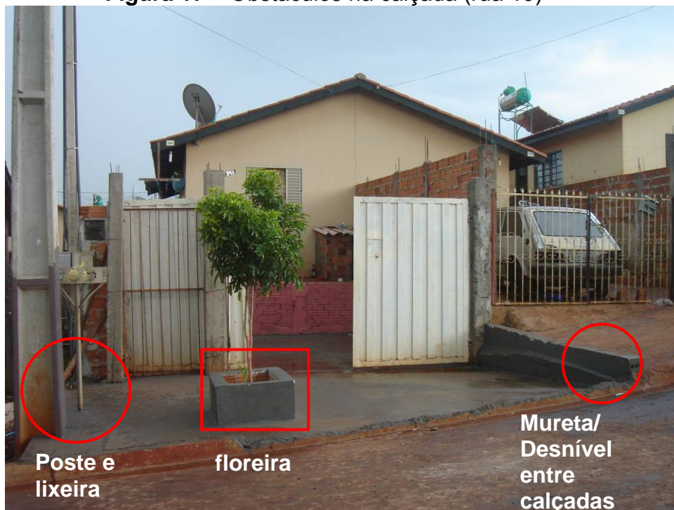
Figura 17 – Obstáculos na calçada (rua 13)
