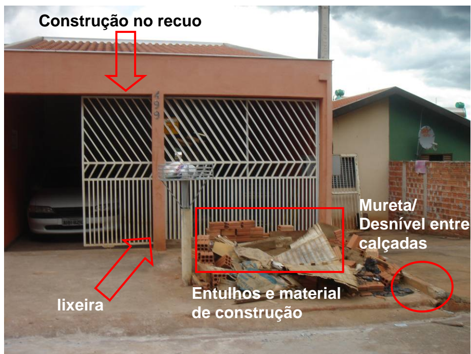
Figura (exemplo 02) – Rua 09 com obstáculos na calçada e quintal
