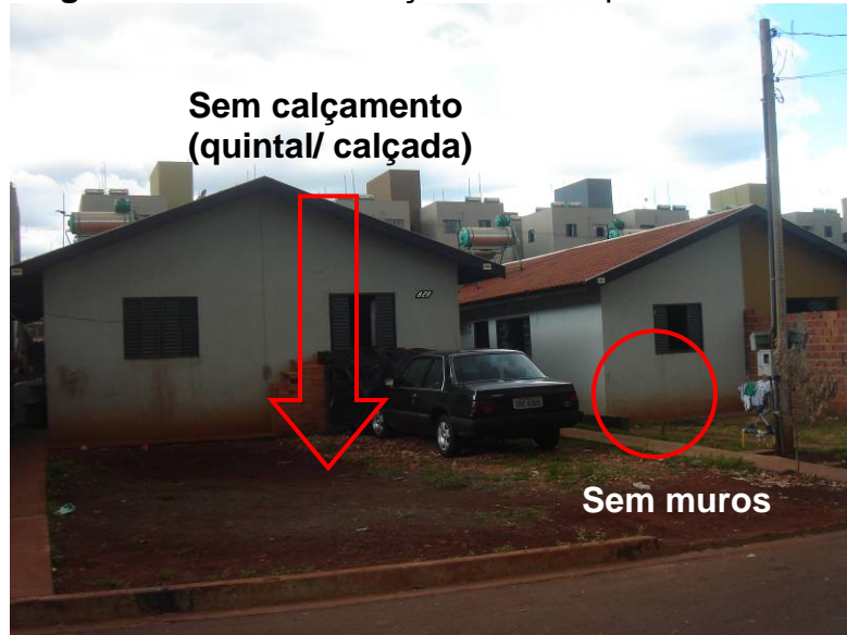
Figura 22 – Falta de calçamento no quintal da casa.
