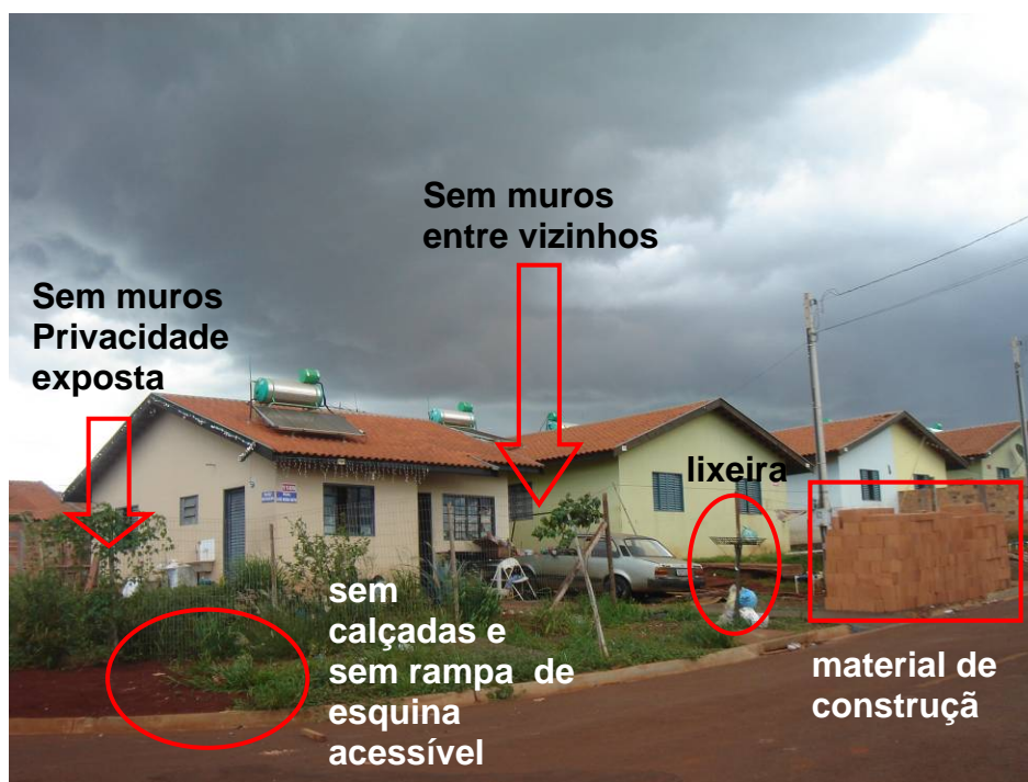
Figura (exemplo 03) – Rua 13 com obstáculos na calçada e quintal
