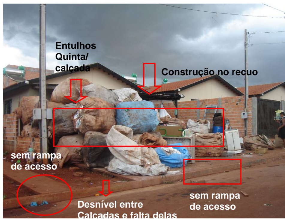
Figura (exemplo 04) – Rua 16 com obstáculos na calçada e quintal
