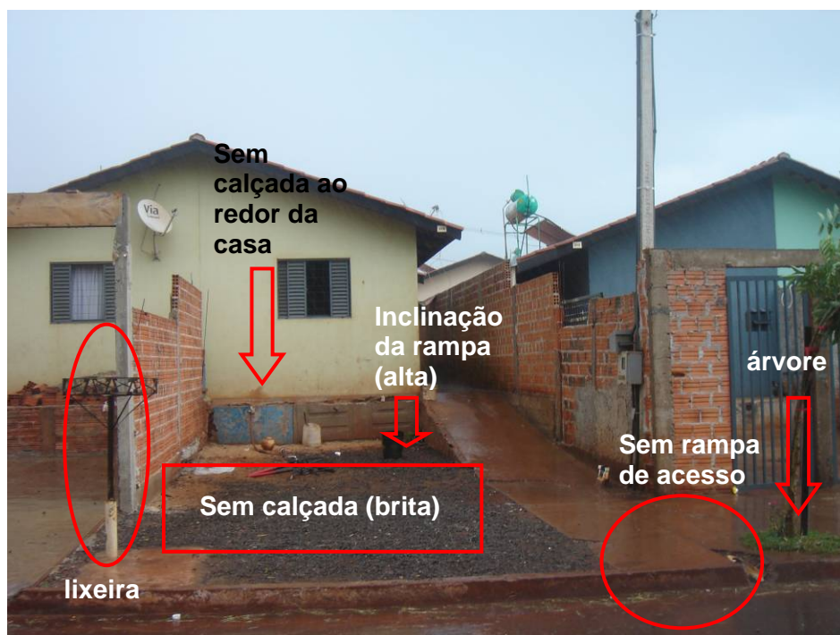
Figura (exemplo 25) – Rua 10 com obstáculos na calçada e quintal
