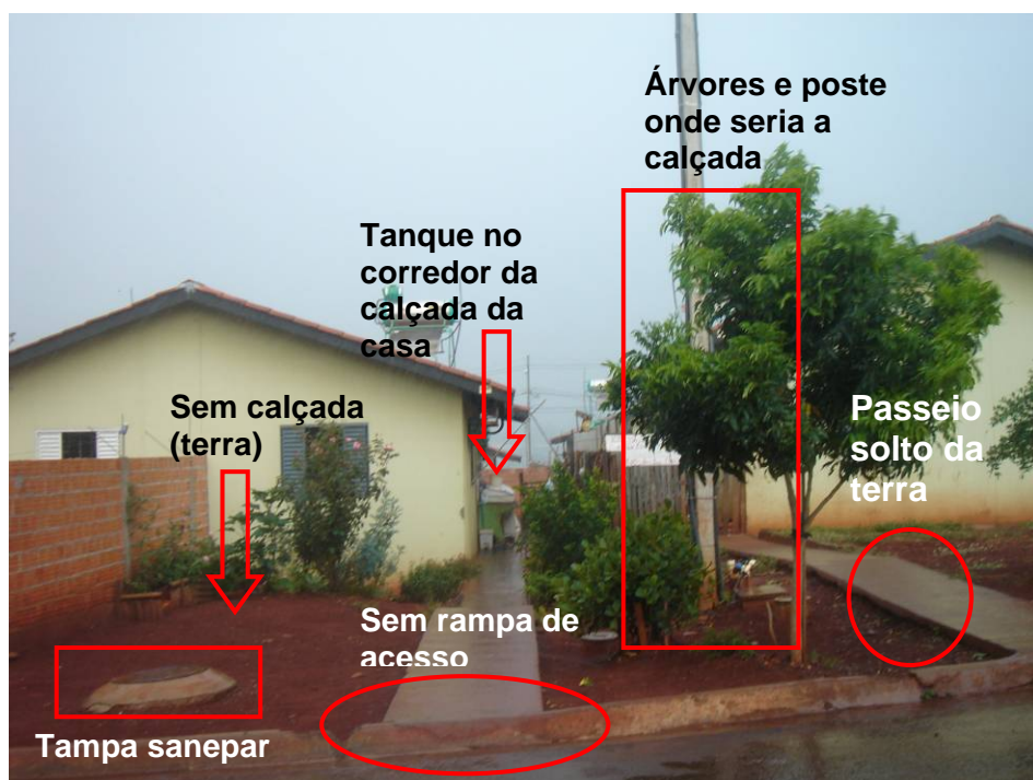
Figura (exemplo 24) – Rua 08 com obstáculos na calçada e quintal
