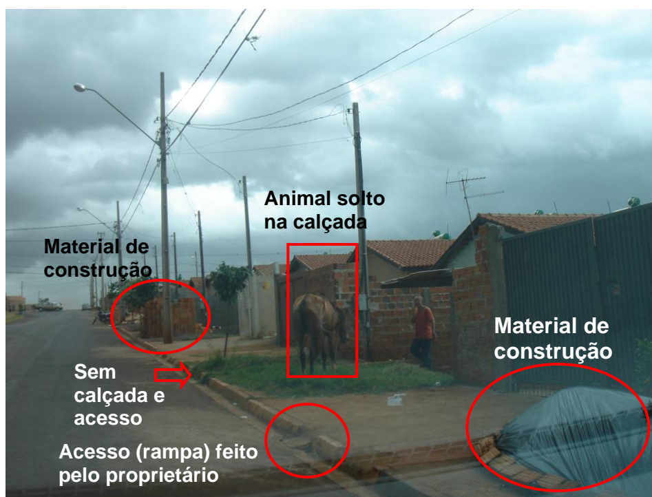
Figura (exemplo 16) – Rua 18 com obstáculos na calçada e quintal
