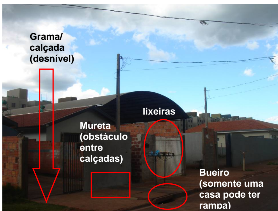
Figura (exemplo 06) – Rua 02 com obstáculos na calçada e quintal
