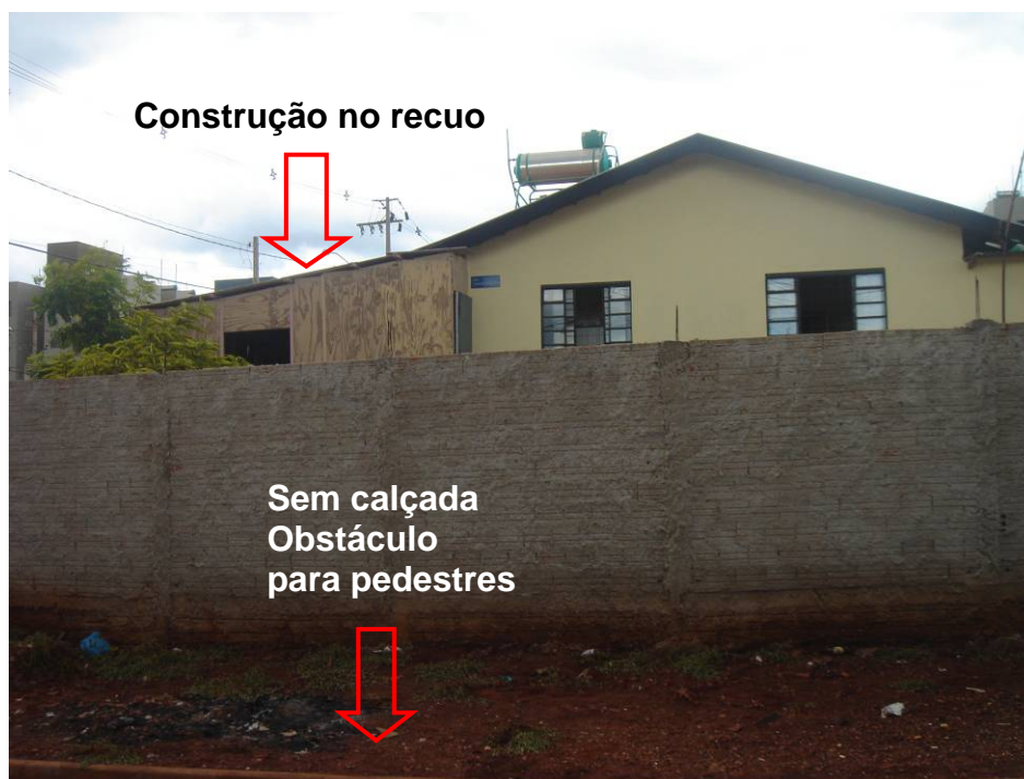
Figura (exemplo 07) – Rua 16 com obstáculos na calçada e quintal
