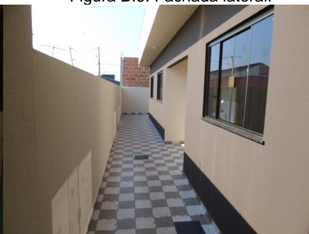
Figura B.6. Fachada lateral.
