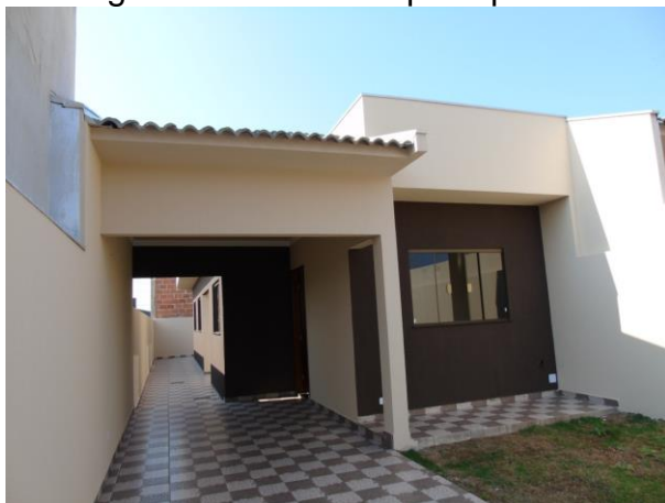
Figura B.1. Fachada principal.
