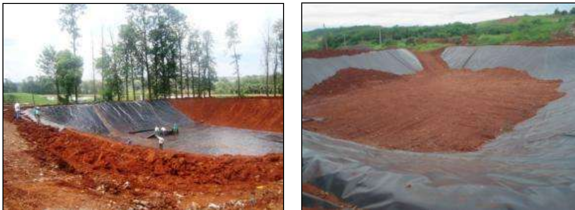
Figura 08: Vala impermeabilizada de Ibiporã-PR, no início de sua construção, em novembro de 2009 onde foram depositados os rejeitos. Autor: Caio Dalla Zanna.
