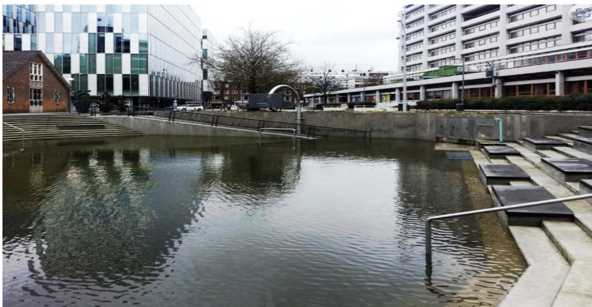
Figura 5 – Sistema de drenagem urbana em Bentemplein, Roterdã
