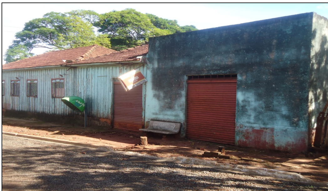
Figura 3 – Antiga casa comercial, hoje desativada em Vila Progresso.
