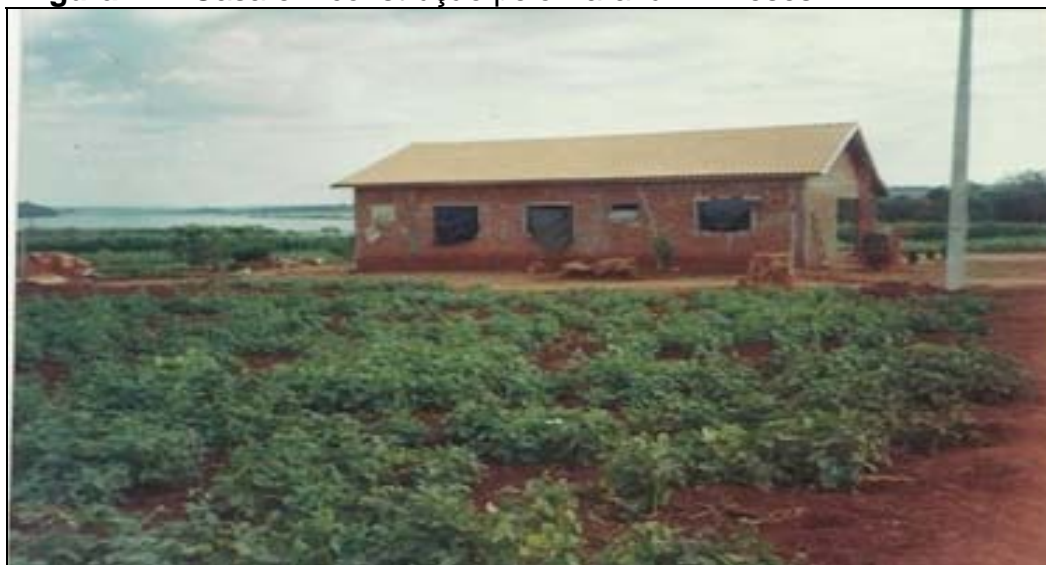
Figura 11 - Casa em construção pelo Paraná 12 Meses
