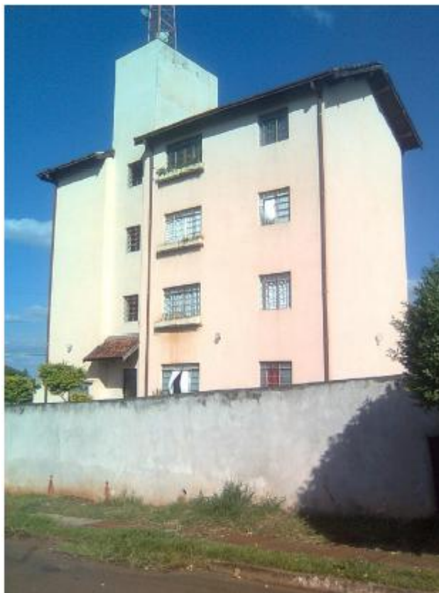
Foto 3 – Residencial Cabo Frio VI.
