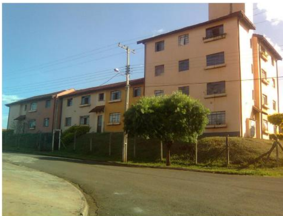
Foto 2 – Residencial Cabo Frio VI.
