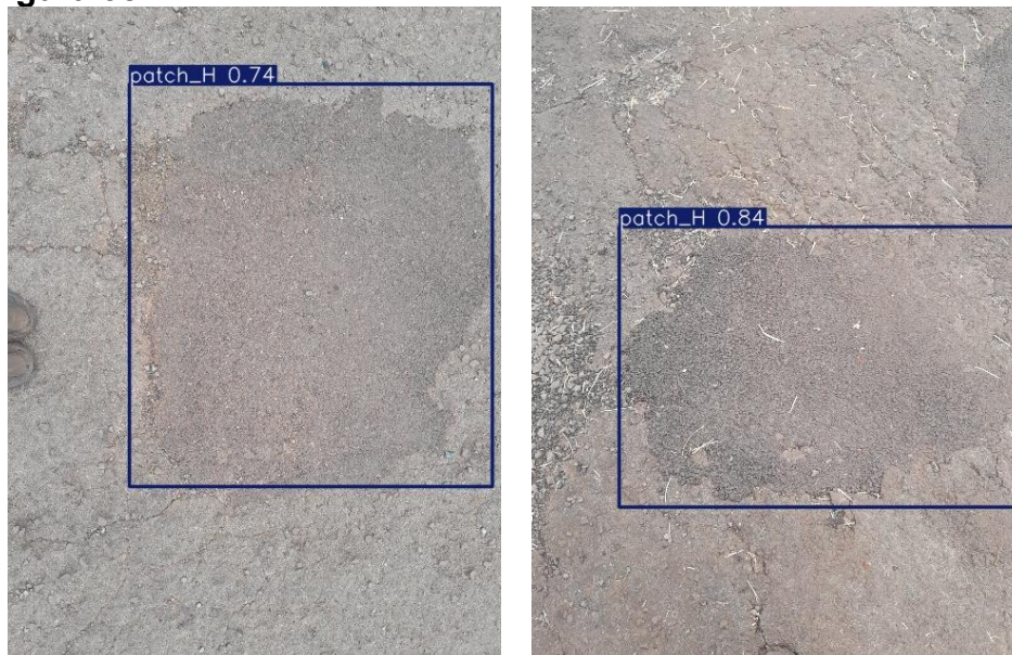
Figura 38 - Remendos severidade média identificados erroneamente
