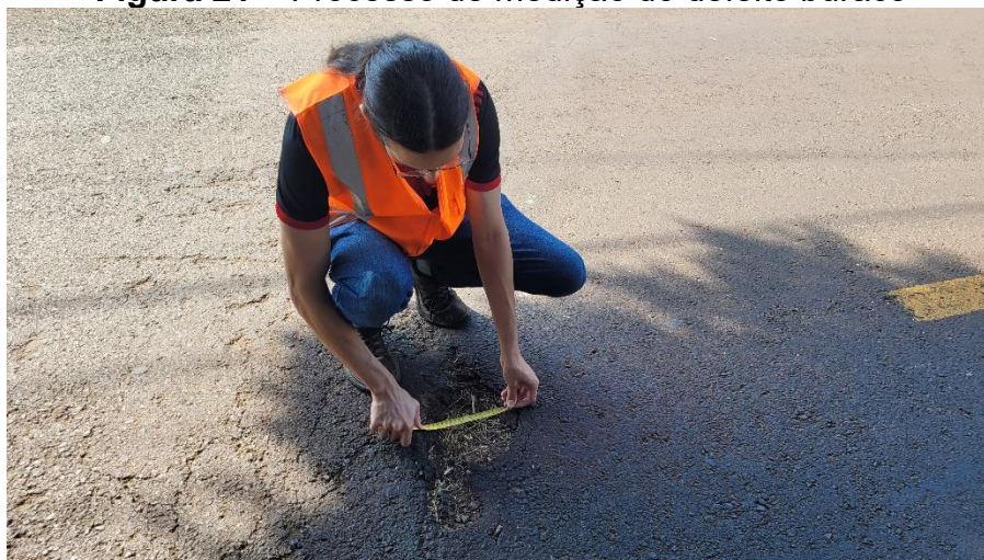
Figura 21 – Processo de medição do defeito buraco
