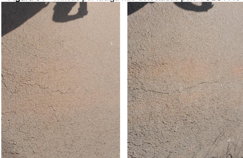
Figura 34 - Trincas por fadiga não detectadas pelo YOLOv11s
