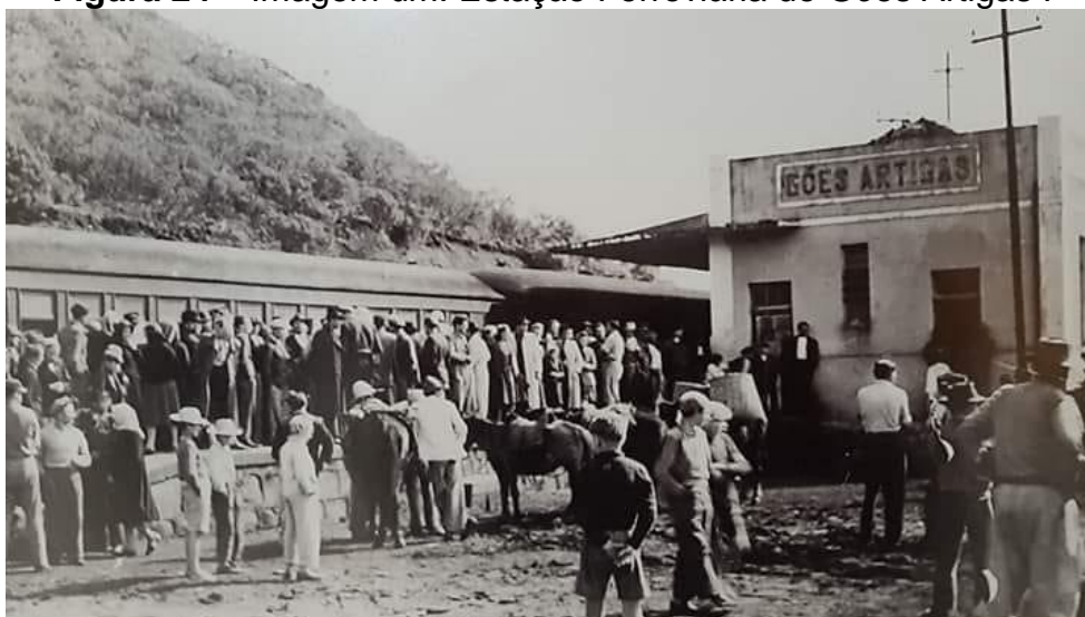
Figura 24 – Imagem um: Estação Ferroviária de Góes Artigas I
