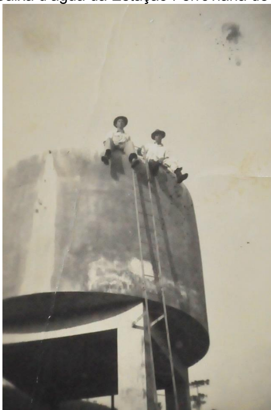
Figura 9 – Caixa d'água da Estação Ferroviária de Góes Artigas
