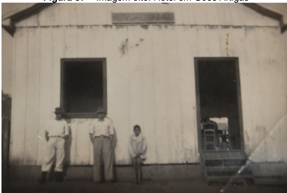
Figura 37 – Imagem oito: Hotel em Góes Artigas
