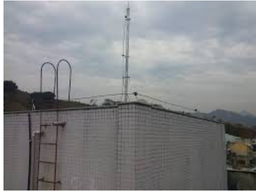
Fig.07- Sistema de SPDA com captor
