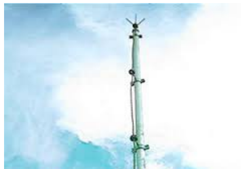
Fig.05-Captor Franklin com cabo de descida de isoladores
