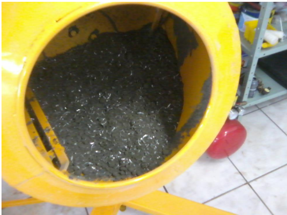
Figura 32 – Argamassa durante a mistura, parcialmente hidratada para o controle de suspensão do pó de pedra, potencialmente nocivo devido à silicose.
