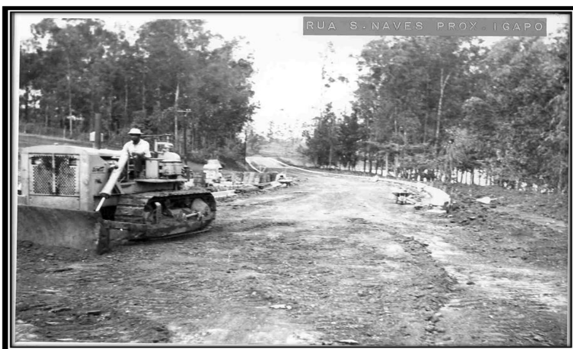
Foto 6 – Serviço de Pavimentação Asfáltica na Rua Senador Souza Naves ao lado Esquerdo do Lago Igapó. Londrina, 30/08/1968.
