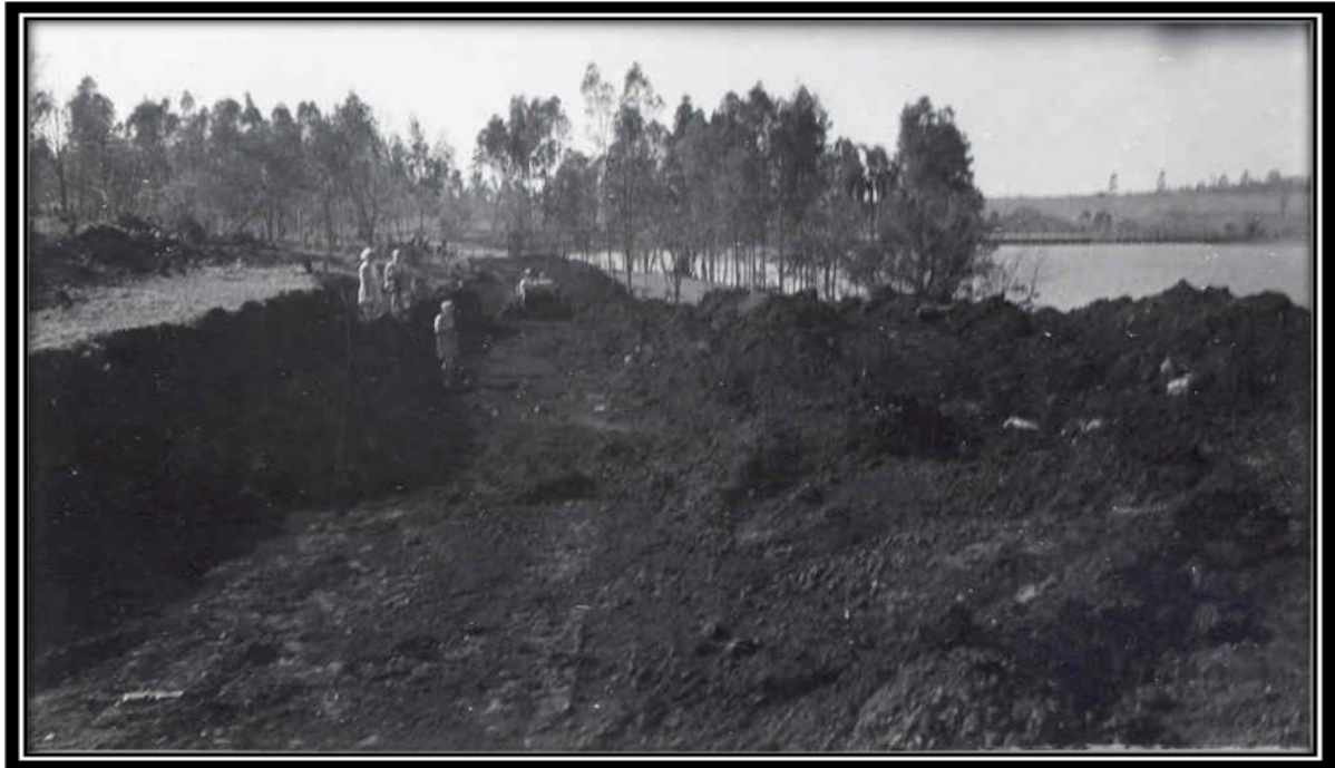
Foto 7 – Construção de uma Avenida Margeando o Lago Igapó, em 20/08/1969. Fonte: Acervo do PML
