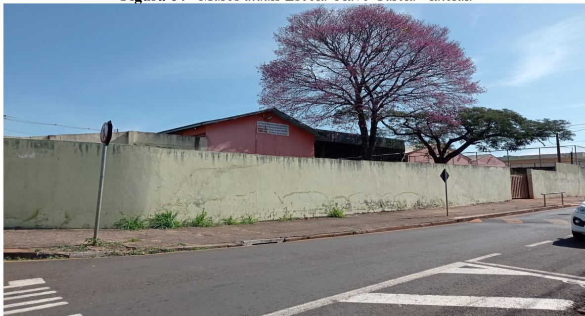
Figura 64 - Muros atuais Escola Olavo Garcia - lateral.
