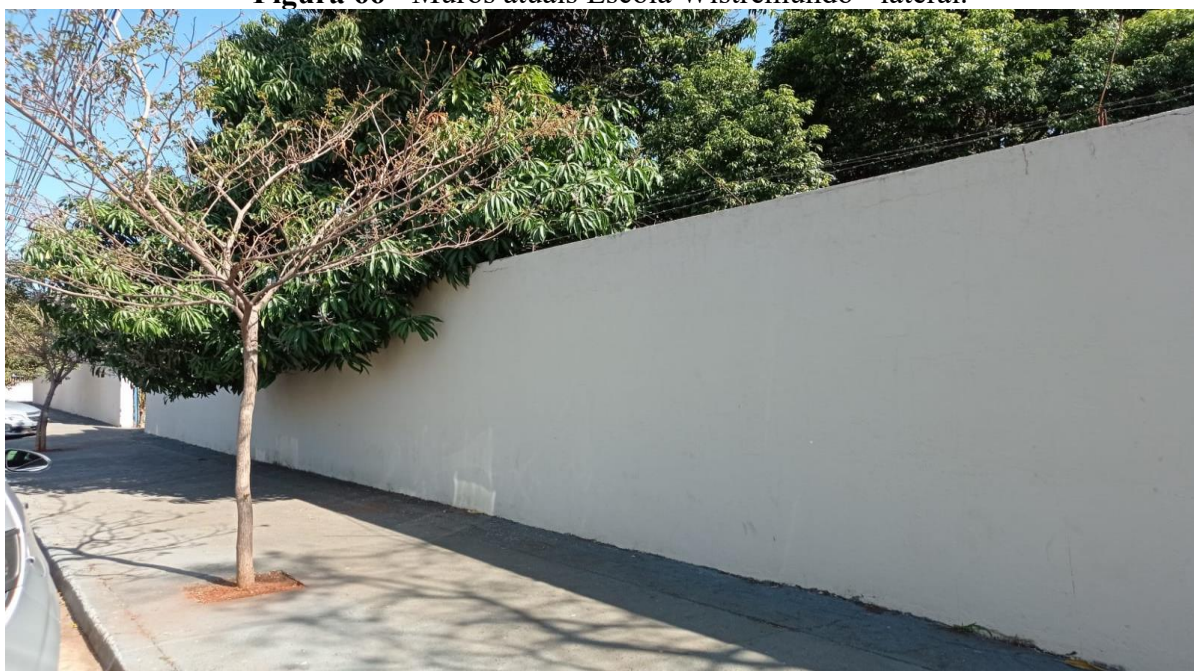
Figura 66 - Muros atuais Escola Wistremundo - lateral.
