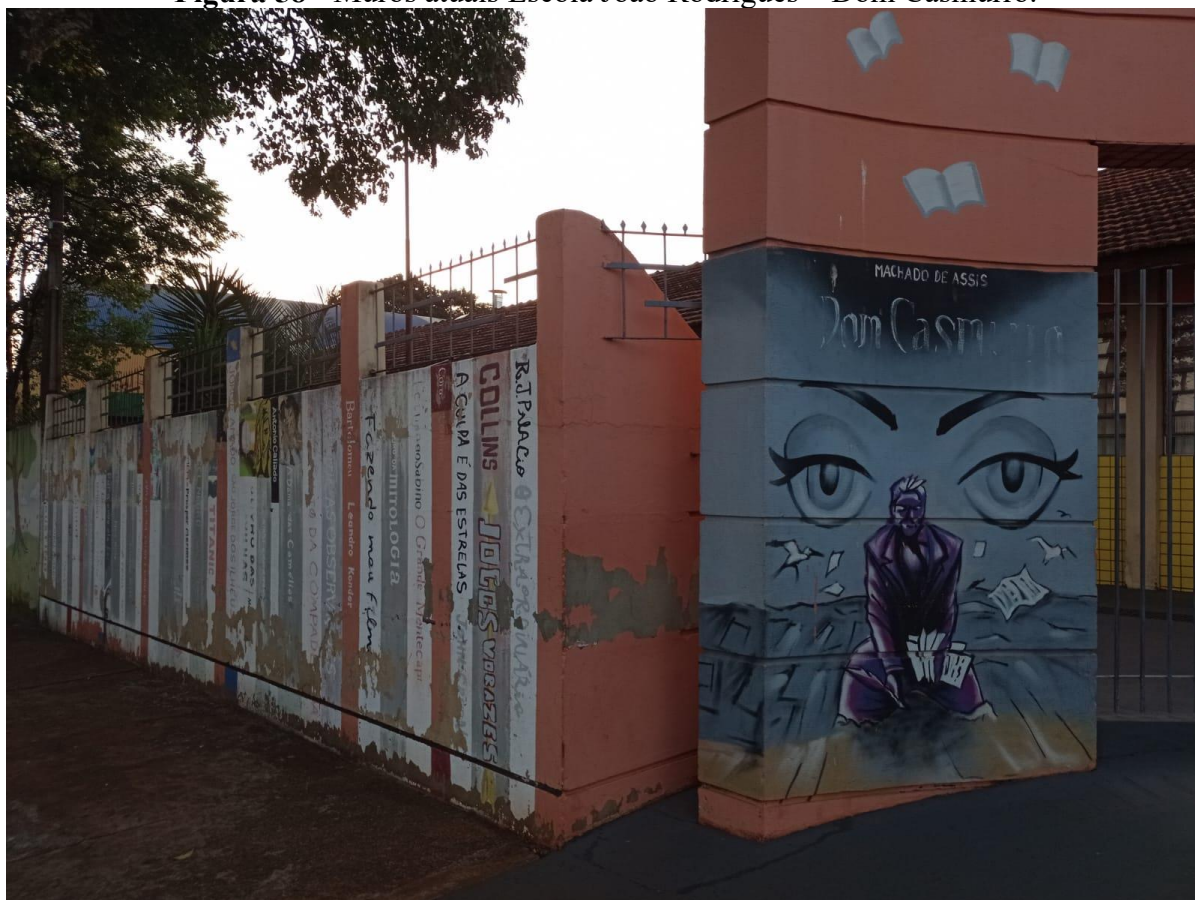
Figura 58 - Muros atuais Escola João Rodrigues – Dom Casmurro.
