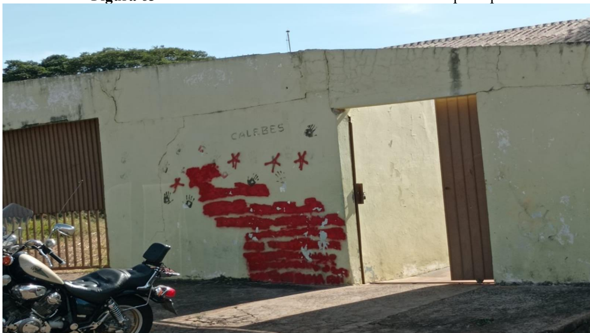
Figura 63 - Muros atuais Escola Olavo Garcia – entrada principal.
