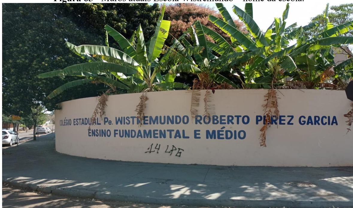
Figura 65 - Muros atuais Escola Wistremundo – nome da escola.
