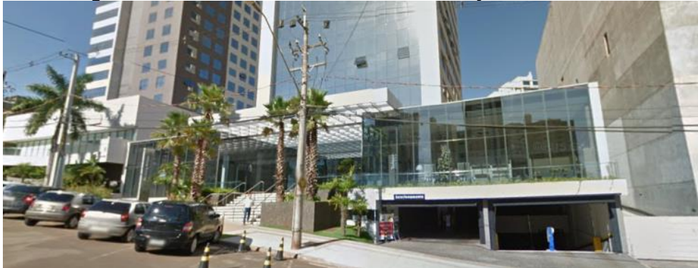
Figura 20: Térreo edifício comercial na Av. Ayrton S. da Silva.
