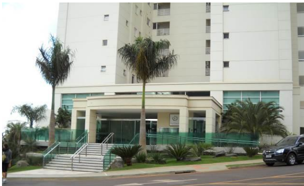
Figura 65: Esquina R. João Wyclif com R. Caracas - Ed. Maison Victoria
