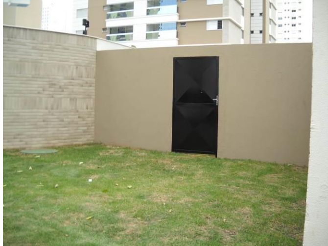
Figura 64: Recuo no muro do Ed. Fernando Pessoa.
