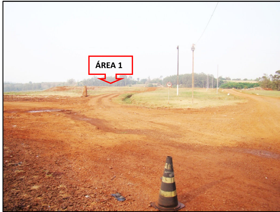
Figura 3.15: Vista geral da área 1 do aterro controlado de Londrina
