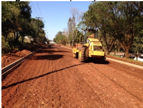
Figura 2 - Compactação de solo
