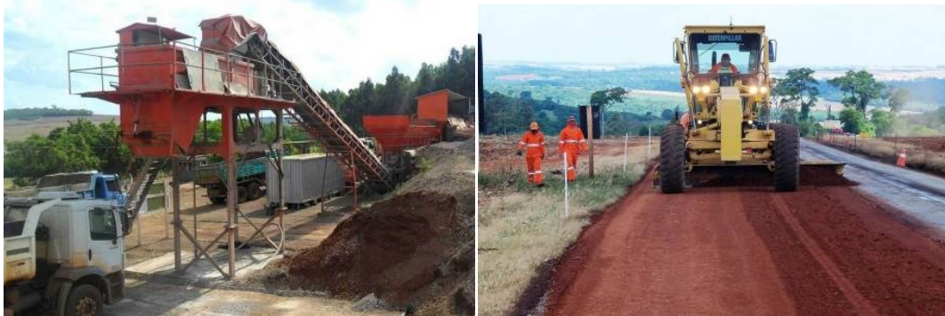
Figura 3 - Usina de solos e mistura em pista
