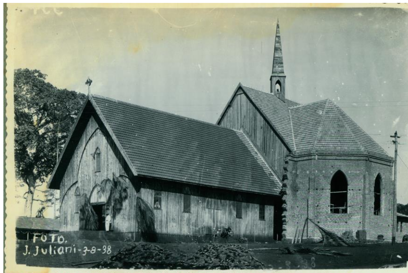
Figura 12: Construção da nova Igreja Matriz em alvenaria (1938).
