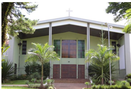
Figura 83: Fachada da Igreja Nossa Senhora de Lurdes (2017).
