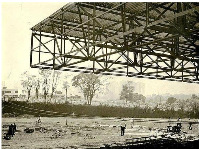
Figura 5: Estrutura metálica em evidência durante a construção do Moringão, 1970.
