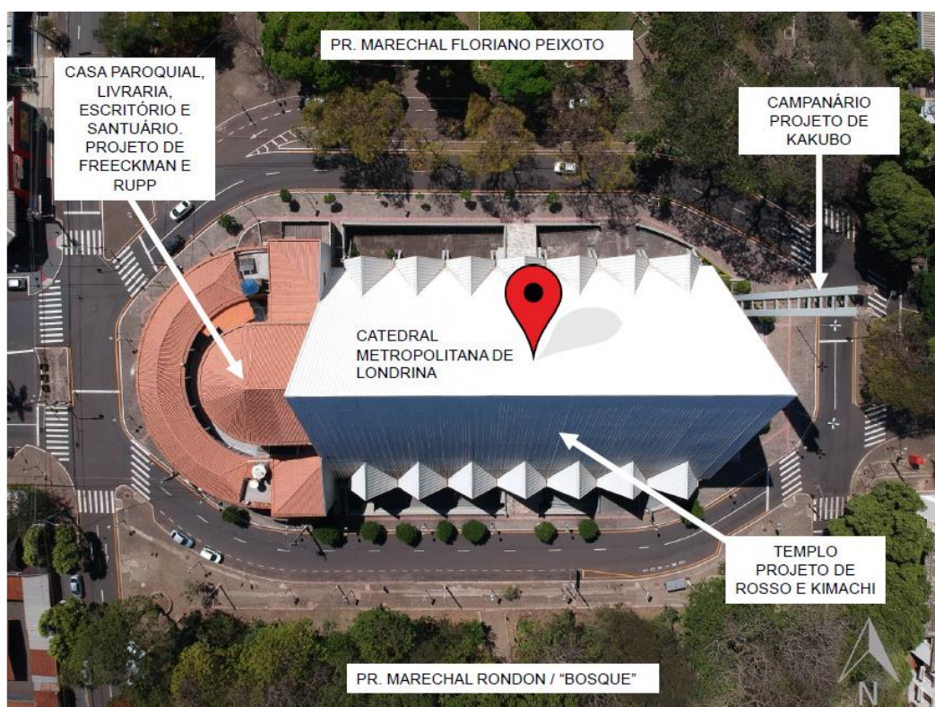
Figura 92: Vista aérea da Catedral. 2018.
