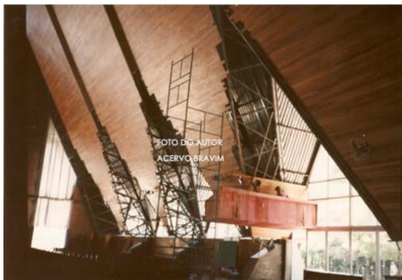
Figura 102: Obra da colocação do forro de madeira. 1992
