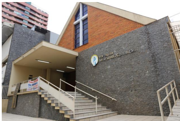
Figura 55: Vista da Igreja Imaculada Conceição a partir da rua Belo Horizonte
