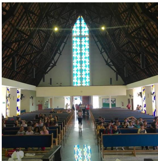
Figura 45: Vista do mezanino e treliças de madeira aparente. 2016
