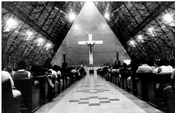
Figura 101: Vista interna da Catedral Metropolitana de Londrina, sem forros, com placas vinílicas no piso e litocerâmica no altar (1974)
