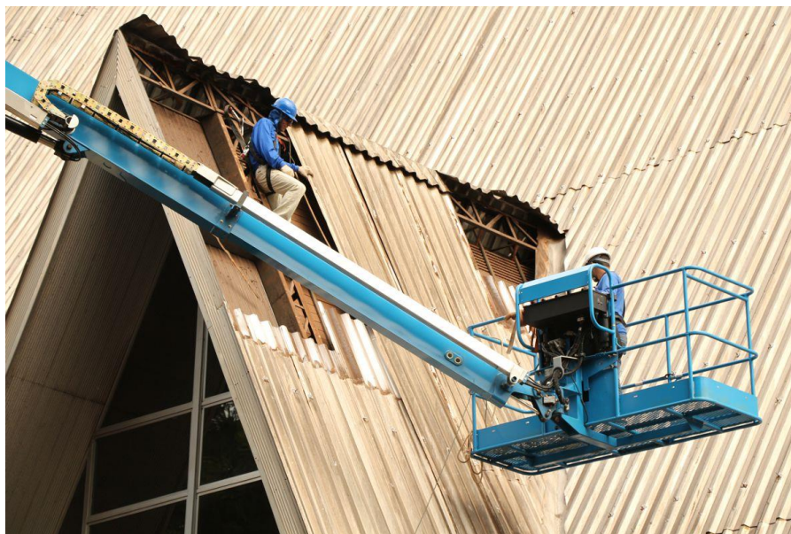
Figura 108: início das obras de troca da cobertura da Catedral (2014).
