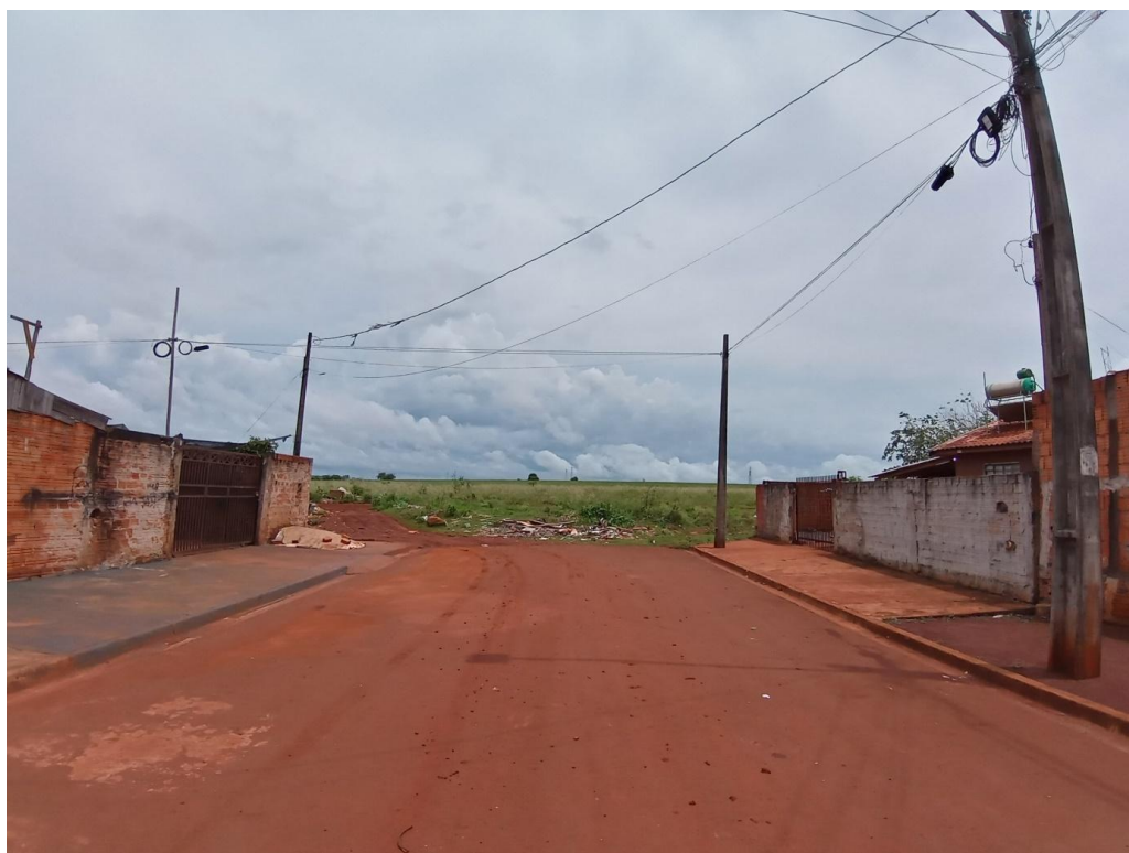
Figura 31 - Desconexão com o entorno imediato (oeste do empreendimento).
