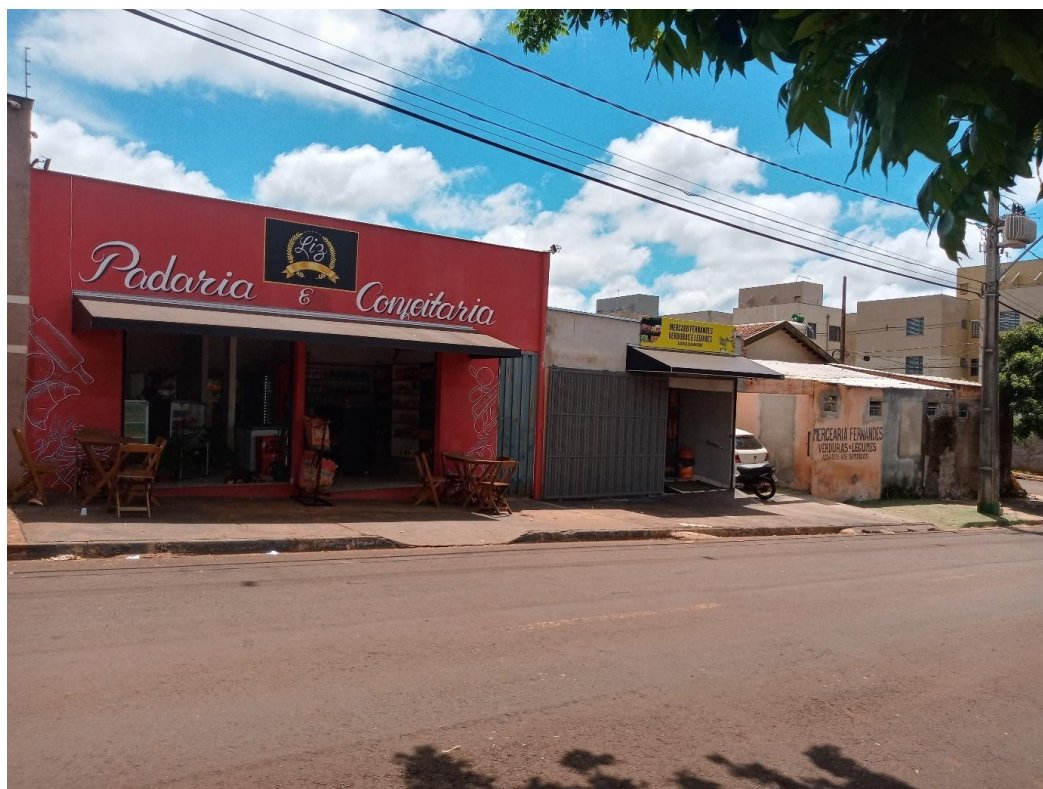
Figura 38 - Fotografias de Residências Adaptadas para Uso Misto (padaria e confeitaria)
