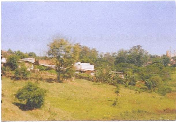
Foto 2 – Bairro Jardim Silvino (Cambé), e as construções irregulares em fundo de vale.
