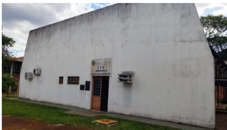
Figura 30 – Fachada leste do Laboratório de Materiais de Construção do CTU/UEL
