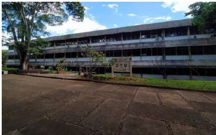
Figura 29 – Fachada norte da Central de Salas de Aula do CTU/UEL
