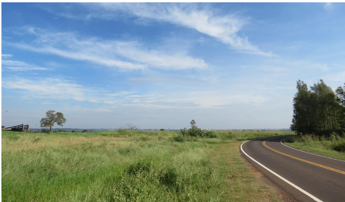
Figura 64 – Curva na rodovia, antiga Estrada NOB entre Recta Grande e Biriguy
