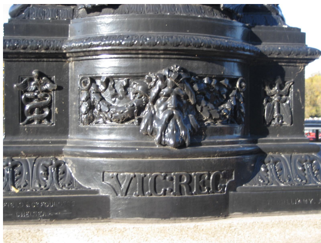
Figuras 60 e 61: Detalhe das luminárias de South Bank Thames River – Londres, 2006
