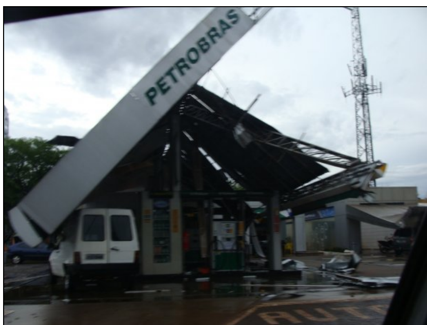
Figura 93 - Cobertura de posto de gasolina em Cascavel totalmente destruída, devido aos ventos fortes que atingiram o município no dia 14/10/2009. Fonte: Jornal O Paraná.
