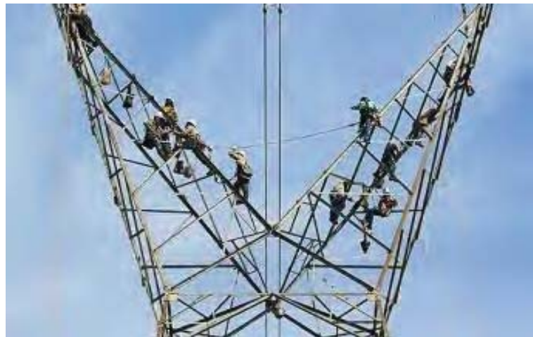
Figura 2.9 – A estatal Furnas Centrais Elétricas anunciou em 18/08/2010 que instalou os reforços nas 70 torres de transmissão da linha de transmissão que sai da hidrelétrica de Itaipu, em Foz do Iguaçu (PR), e chega à subestação de Ivaiporã (PR), linha que ocasionou falha de energia (“apagão”). Fonte: Furnas Centrais Elétricas.
