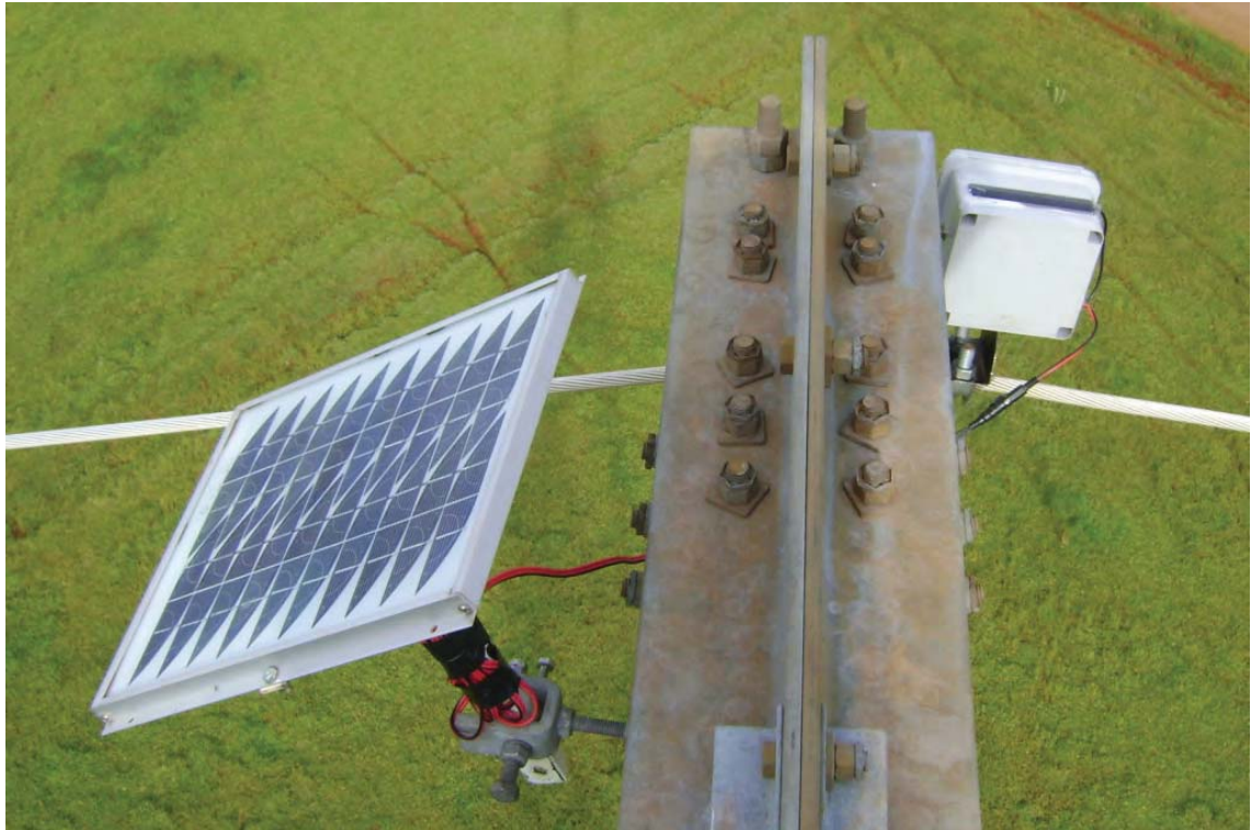
Figura 4.6 – Montagem do painel solar. Foto: o autor.
