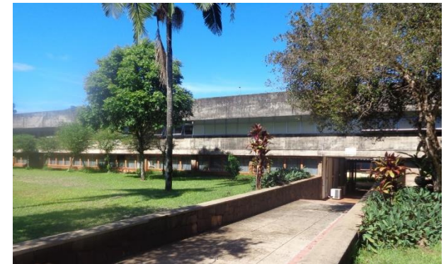
Figura 99 – CCB, bloco de salas de aula (mai.2017)
