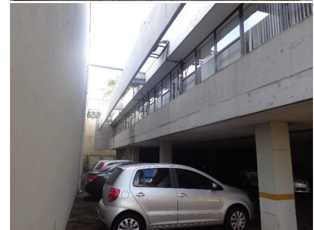
Figura 80 - Fachadas laterais do edifício.
