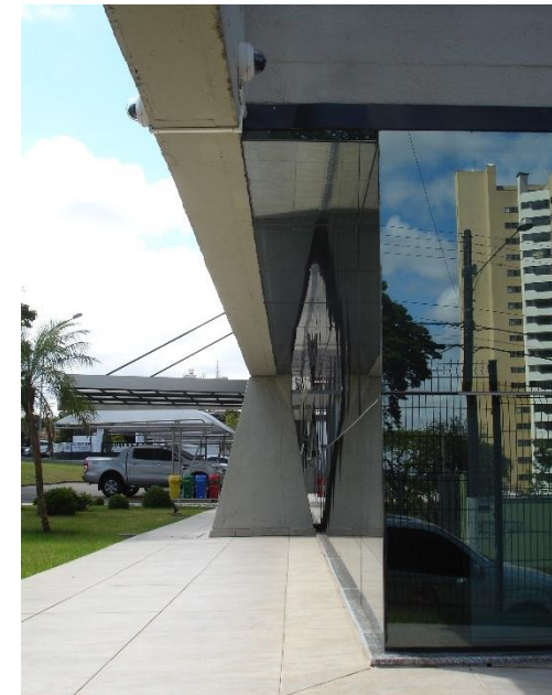
Figura 69 - Detalhe da estrutura. Fonte: acervo da autora.
