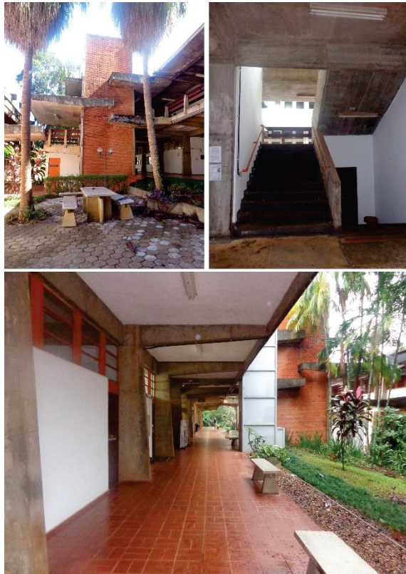
Figura 32 - Escadas do CCE em tijolo e concreto aparente. Circulação externa e ênfase na estrutura do edifício.
