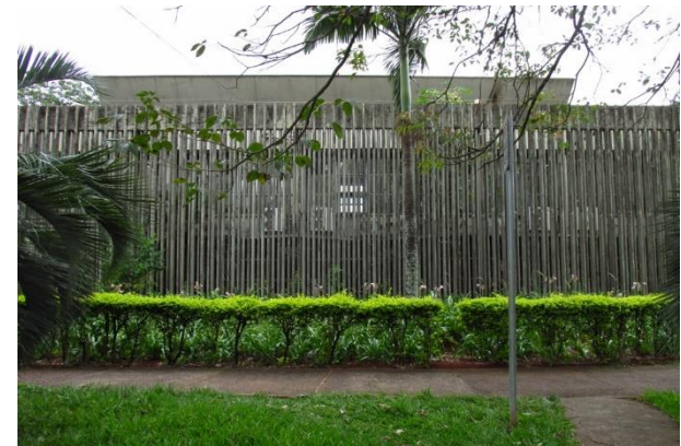
Figura 87 - Elementos vazados e parte da cobertura.
