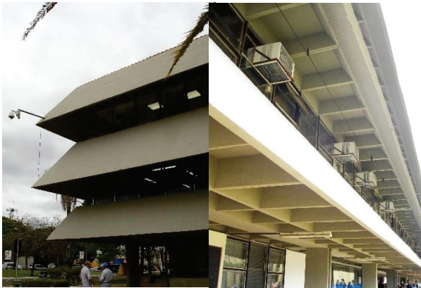
Figura 91 – Detalhe, Laje nervurada e Guarda-corpo
