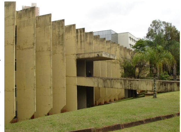
Figura 62 - Acesso ao edifício do Fórum Fonte: acervo da autora
