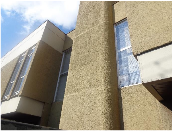
Figura 122 - Detalhe do volume da escada. Fonte: acervo da autora.
