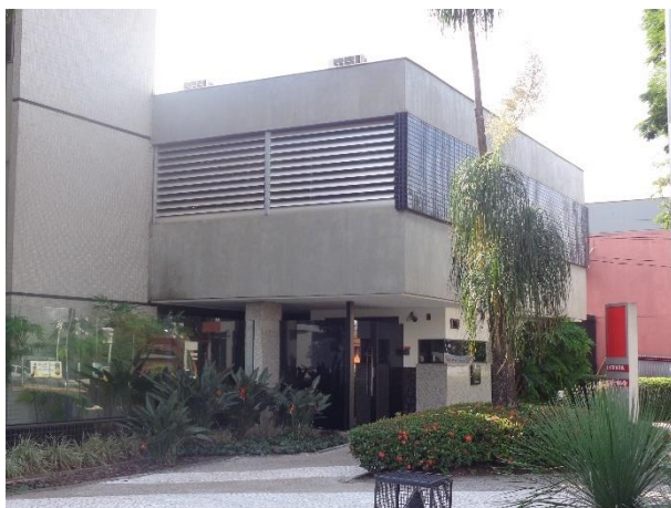
Figura 74 - Brises substituídos
