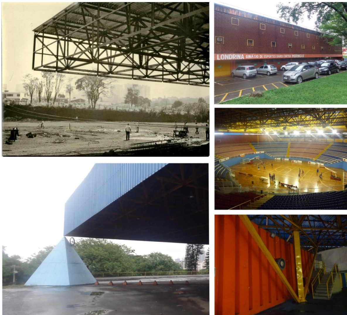
Vista da estrutura treliçada na época de construção do ginásio e atualmente, com pirâmides. À direita e acima, o edifício administrativo com elementos cerâmicos vazados. Ao centro, vista interna do ginásio e abaixo detalhe de um dos quatro pilares em "V".
