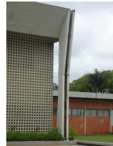
Figura 26 - Detalhe da estrutura
