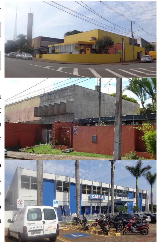
Figura 109 – Antiga SENP, Rua Poços de Caldas, acima, e Av. Tiradentes, abaixo (mai.2017)
