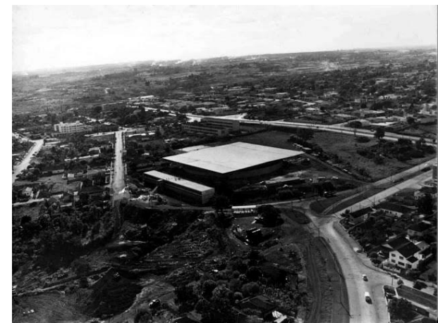
Construção do Ginásio.
