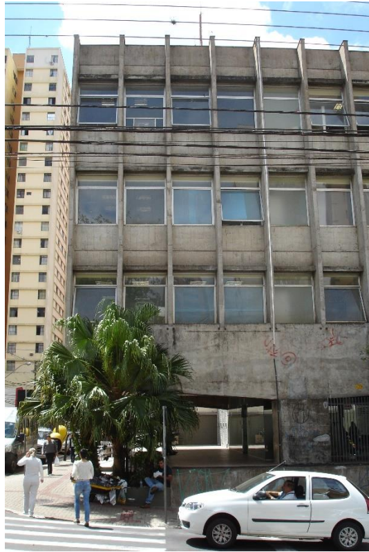
Figura 46 - Detalhe da estrutura
