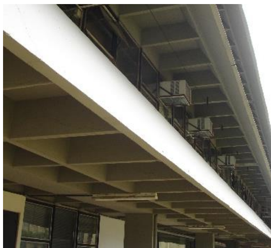
Figura 127 - Teto em grelha: solução adotada para o edifício da Prefeitura de Londrina
