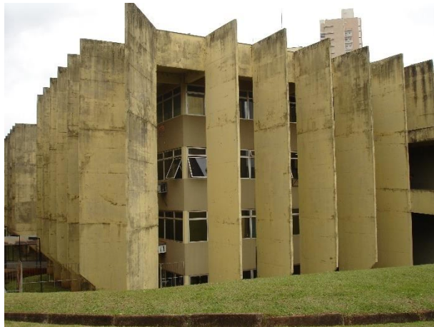
Figura 63 - Brises em torno de todo o edifício Fonte: acervo da autora.
