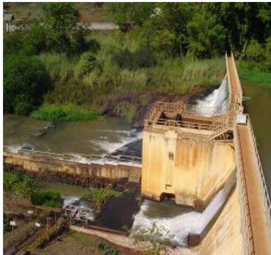
Foto 10 – Visão atual da Usina Hidroelétrica Três Bocas desativada.
