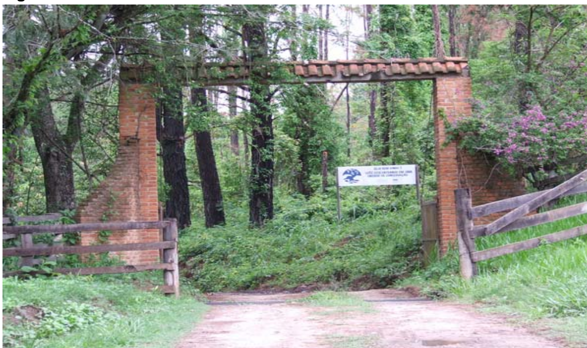
Figura 4 - Portal de entrada do RVSJ - Pr.
