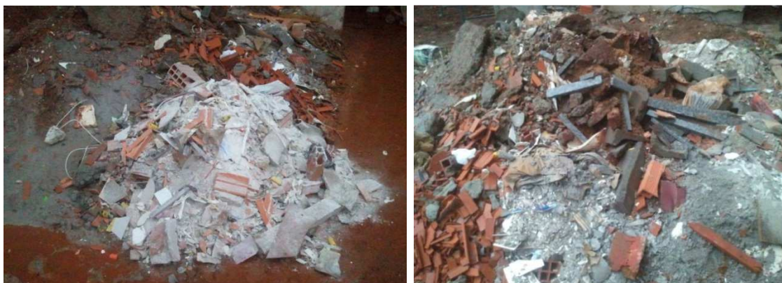
Figura 22: Resíduo Classe A despejado ao longo da Obra B
