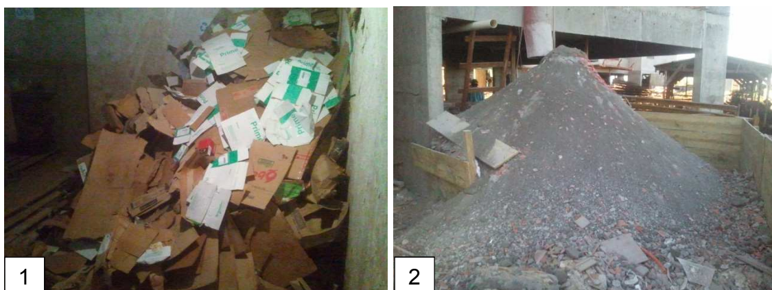
Figura 44 - Resíduos recicláveis (papelão) e de argamassa bem segregados e acondicionados.
