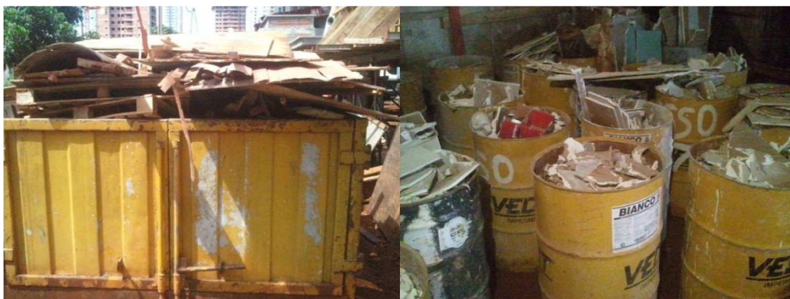
Figura 17 - Caçamba de madeira e tambores de gesso – Obra A.
