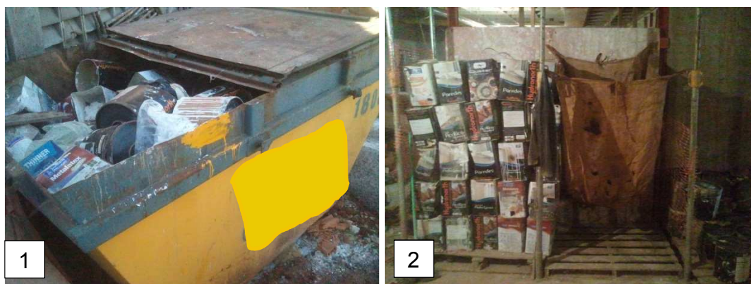
Figura 42 - Resíduos classe D bem segregados e acondicionados.
