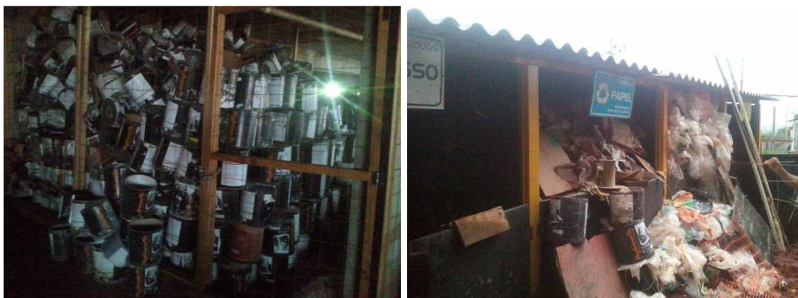
Figura 24 –Resíduos Classe D segregados e baias de resíduos Classe B com papelão e plásticos
