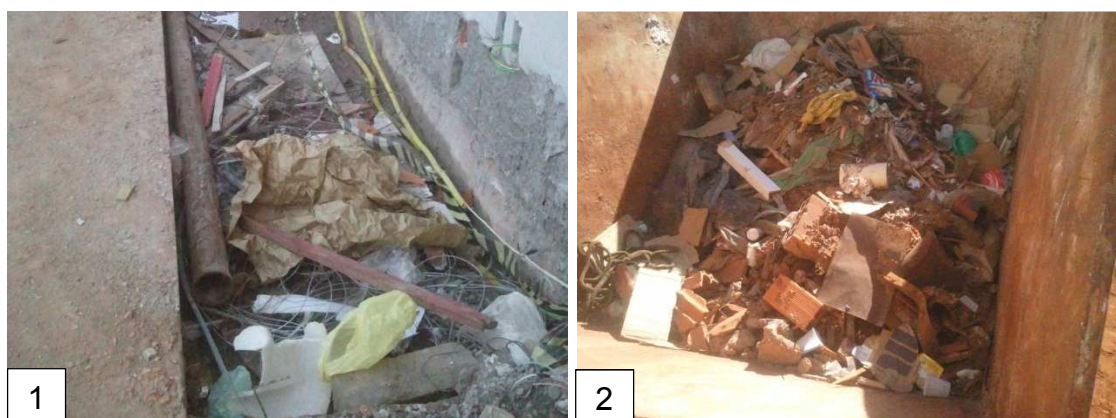
Figura 45 - Condições de limpeza do canteiro de obras e rejeitos de construção civil.
