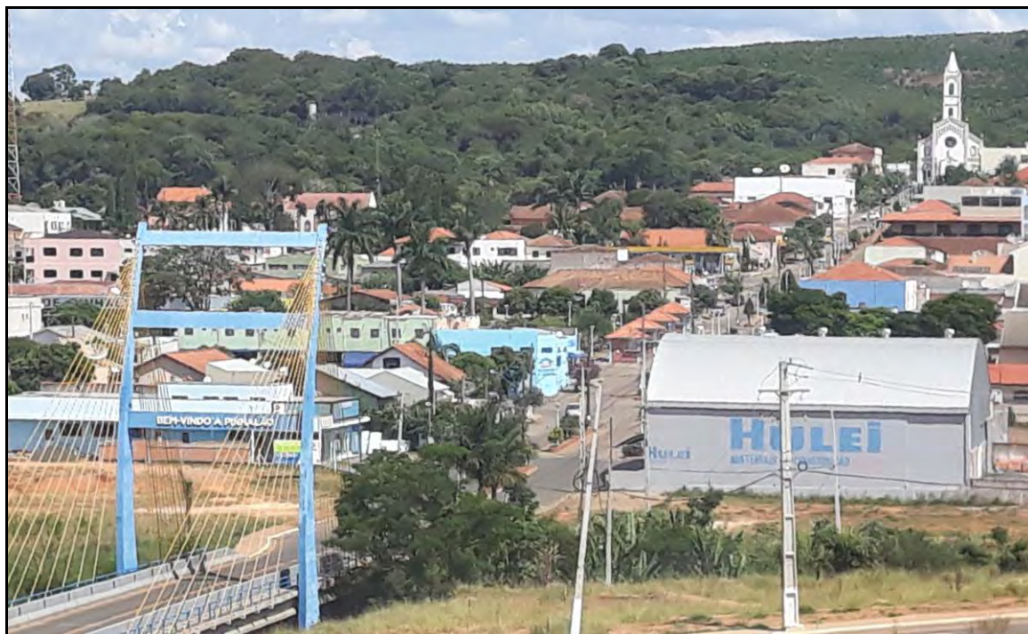
Cidade vista pela rodovia BR-272
