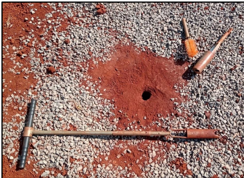
Figura 38 – Kit para execução dos furos de sondagem do ensaio.
