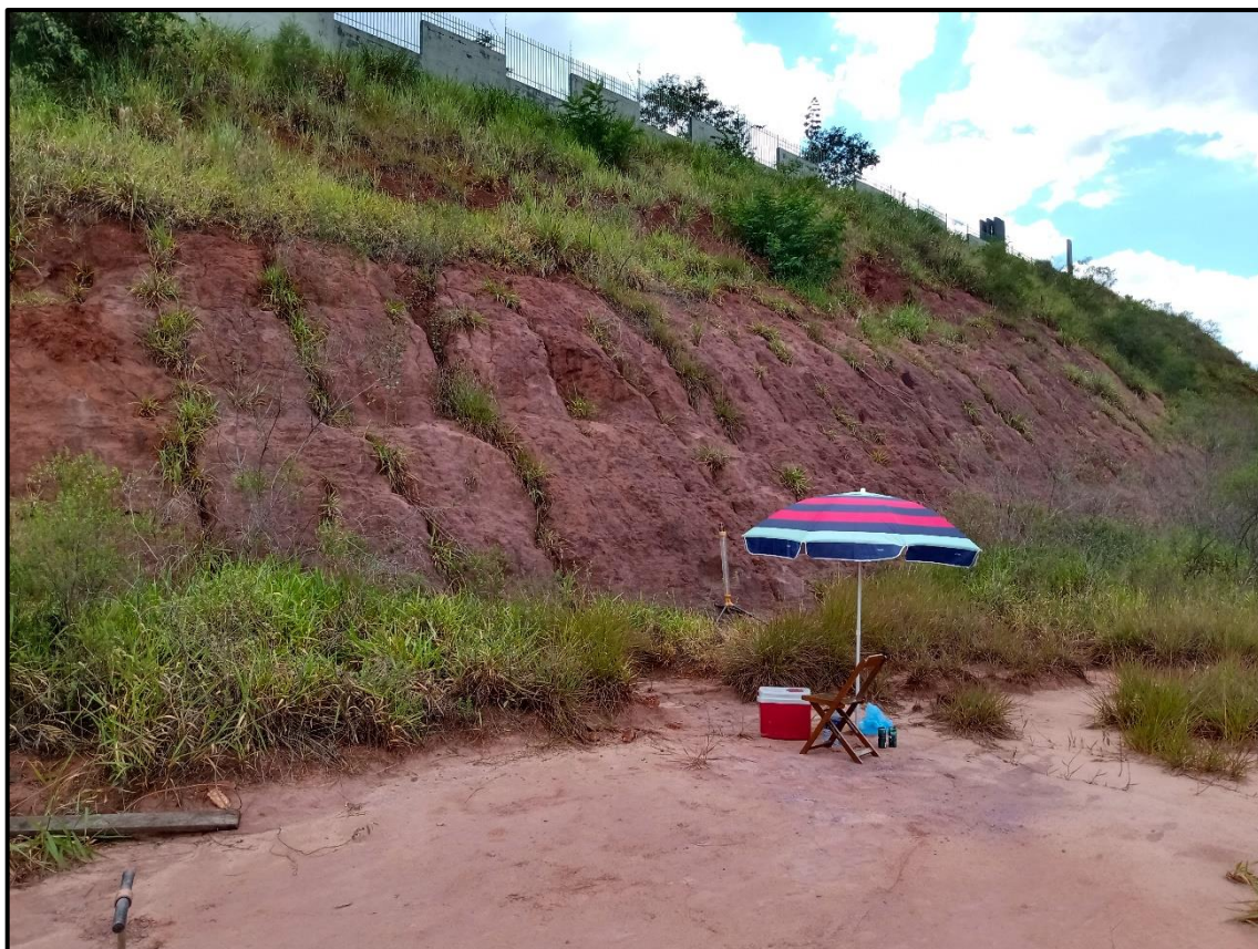
Figura 45 – Talude exemplo – Mandaguaçu.
