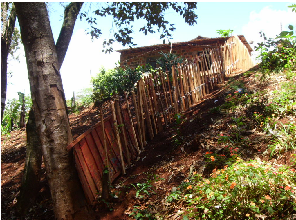
Figura 16 – Foto que demonstra o processo de ocupação irregular no fundo de vale, a menos de 200m da nascente.
