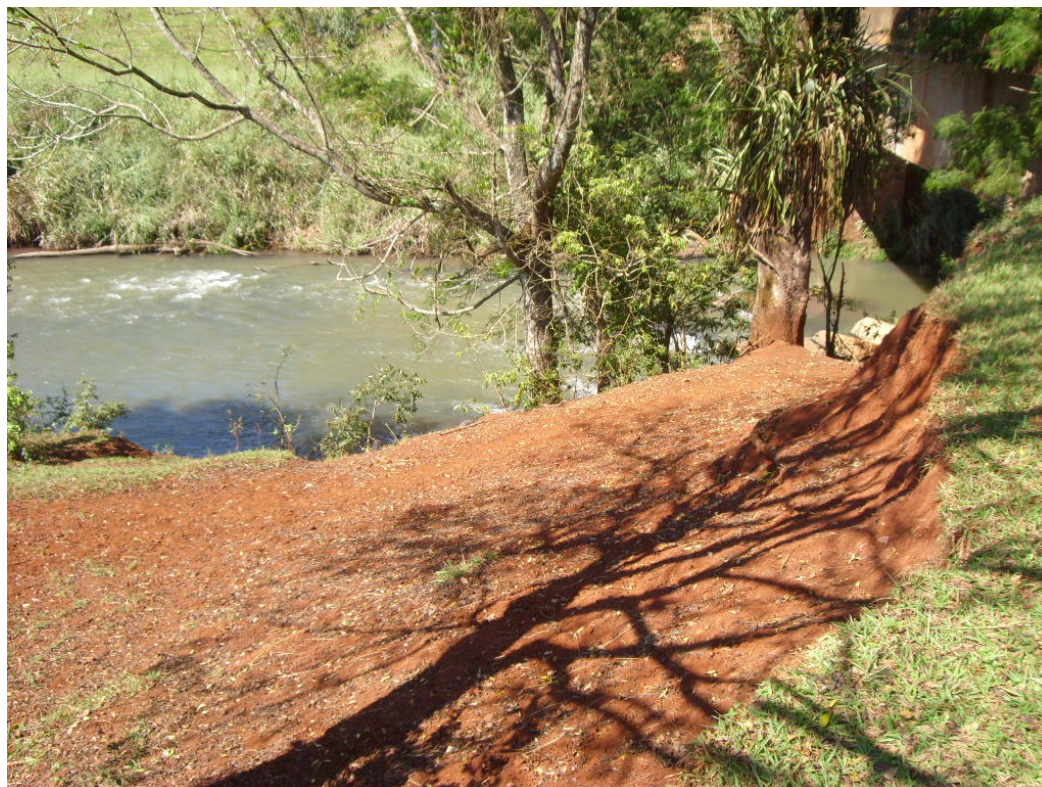
Figura 40 – Processo erosivo na margem esquerda do Ribeirão Taquara em virtude das atividades agropecuárias.
