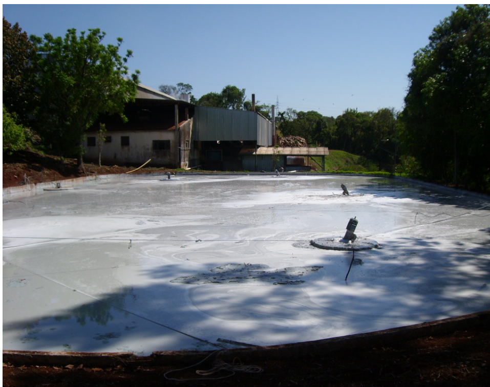
Figura 12 – Foto de uma fábrica de celulose a menos de 50 metros da região da nascente.
