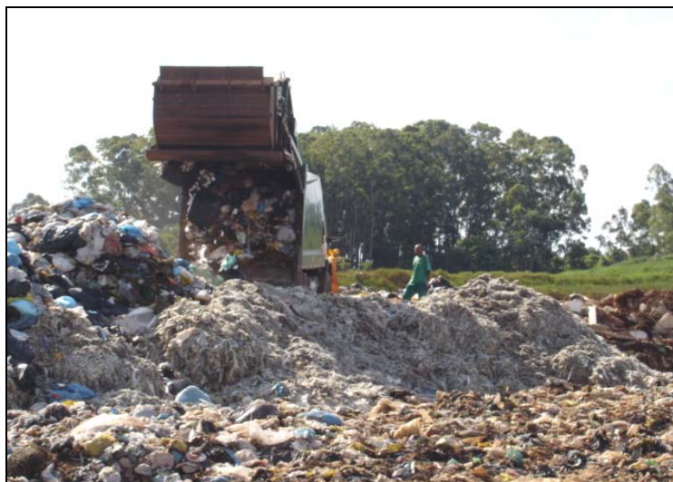
Foto 3 – Despejo do lixo no Aterro Controlado de Londrina
