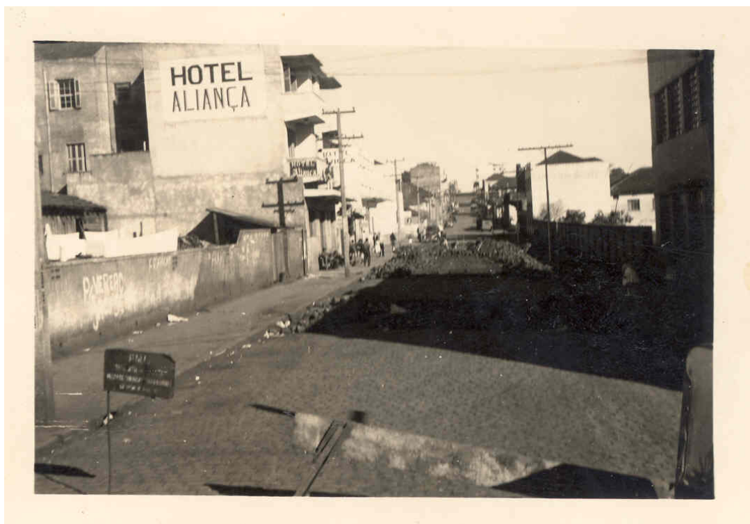
Imagem 31 - Serviço de reconstrução de calçamento. Rua Benjamin Constant.
