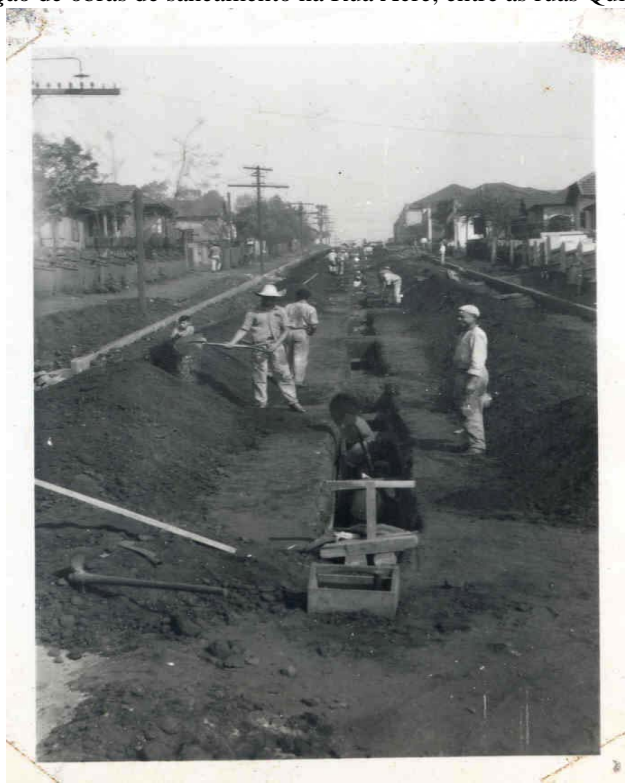
Imagem 9 - Construção de obras de saneamento na Rua Acre, entre as ruas Quintino Bocaiúva e Ceará.
