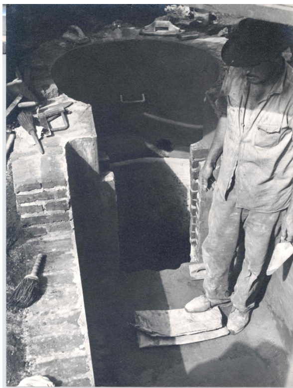
Imagem 12 - Tanque flexível- cruzamento da Avenida Higienópolis.
