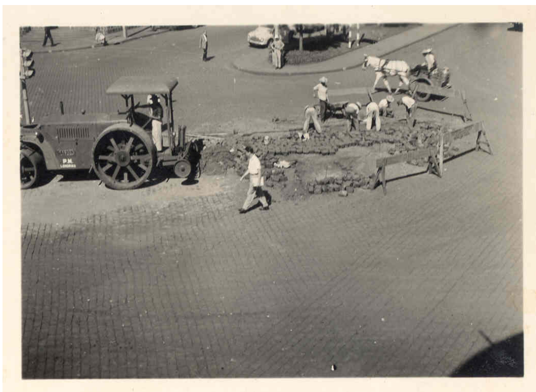
Imagem 26 - Reconstrução do calçamento em frente à Prefeitura.
