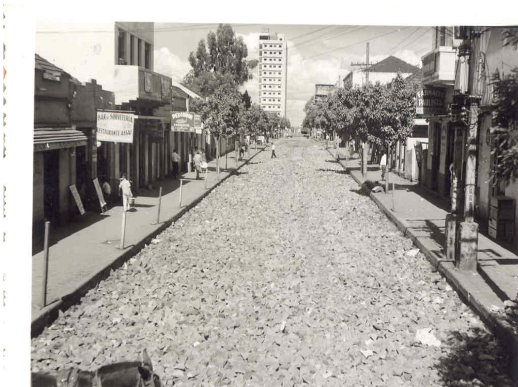
Imagem 27 - Rua Sergipe, em preparo para asfaltamento.
