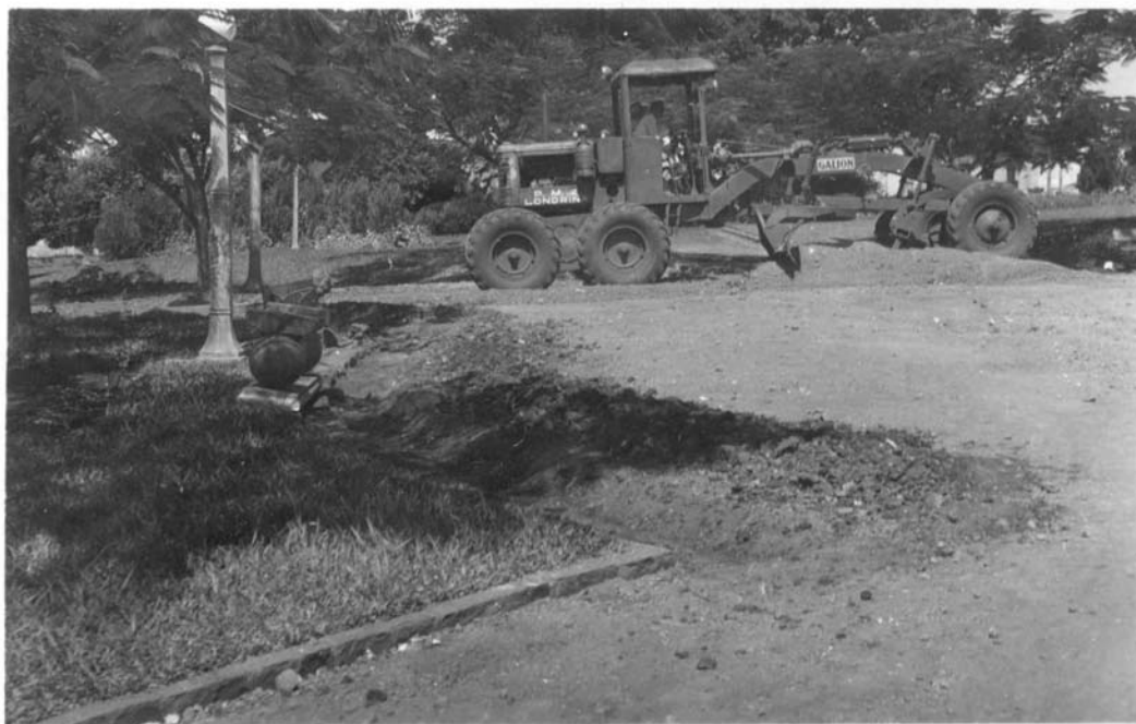
Imagem 39 - Serviços preliminares para asfaltamento, Praça Marechal Floriano Peixoto.
