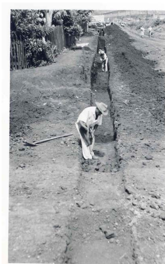
Imagem 33 - Rua Alagoas. Serviço de galeria.
