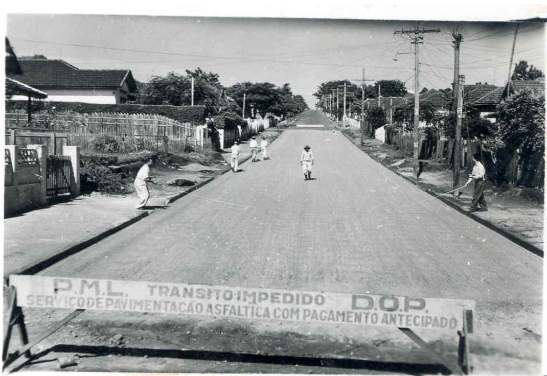
Imagem 29 - Pavimentação asfáltica da Rua Sergipe.
