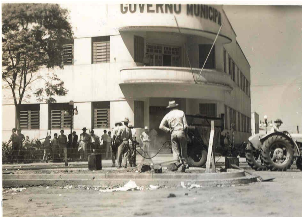
Imagem 23 - Pavimentação da Avenida Paraná.
