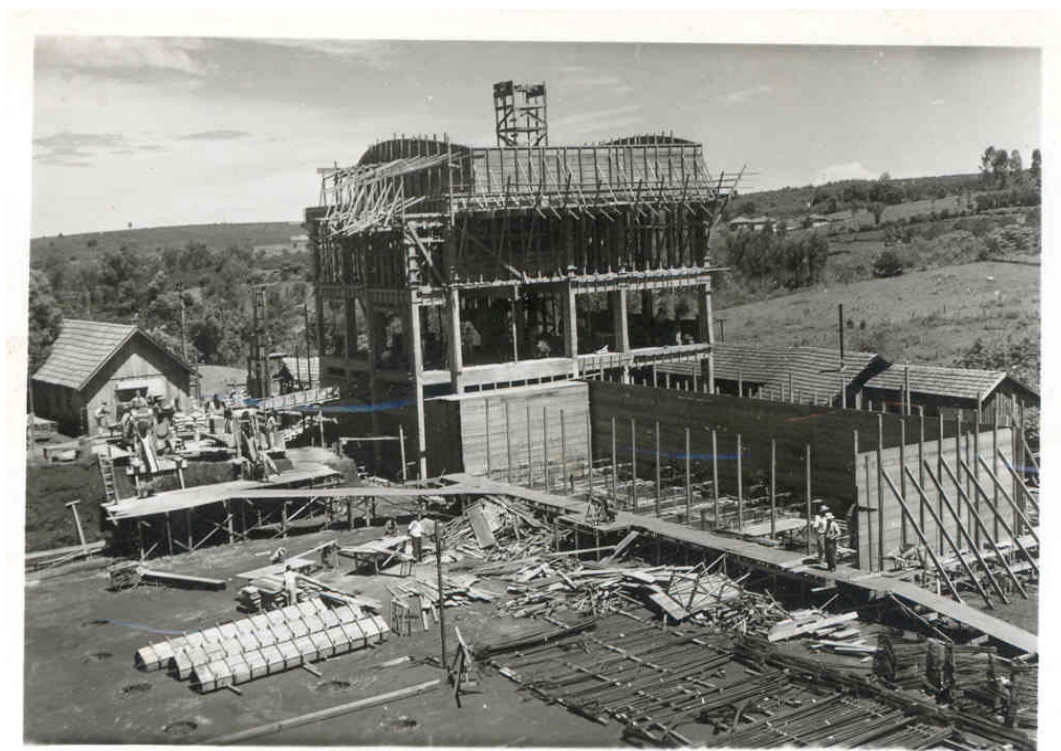
Imagem 14 - Construção de Estação de Tratamento.
