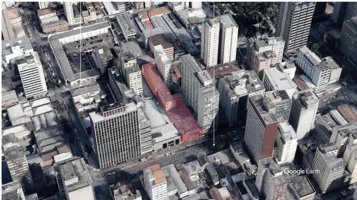
Figura 15- Vista aérea: Galeria Suíssa R. José Loureiro 13 Gal. Suíssa R. Mal. Deodoro
