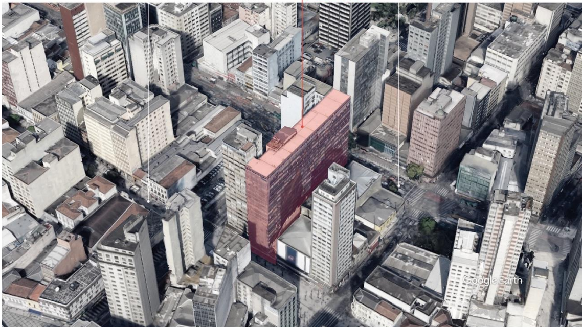
Figura 11- Vista aérea: Galeria Ritz R. XV de Novembro 9 Gal. Ritz R. Mal. Deodoro
