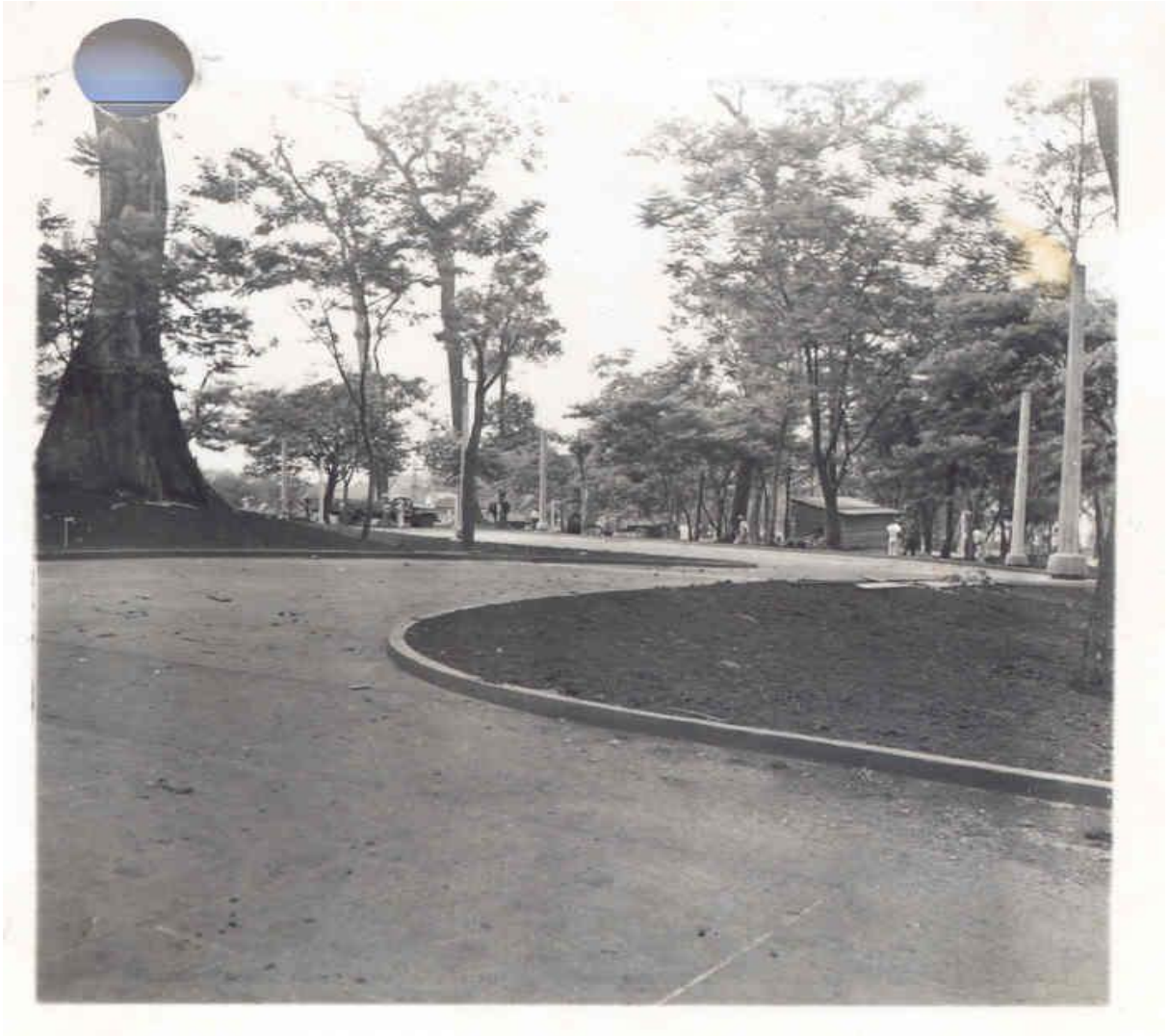
Figura 10 – Revitalização do bosque. Fim de obra.
