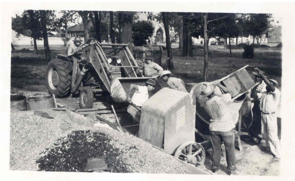
Figura 6 – Bosque na área central. Realização das obras de urbanização.
