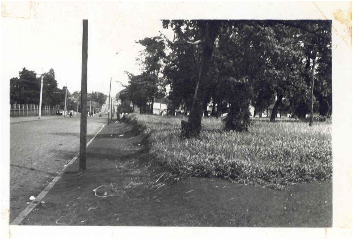
Figura 4 – Bosque na área central de Londrina. Início da execução do projeto de urbanização.
