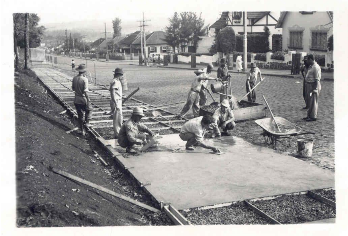
Figura 5 – Bosque na área central. Execução do projeto de urbanização.
