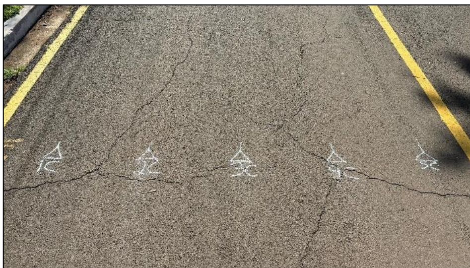
Figura 4.13 – Marcações das linhas de passagem
