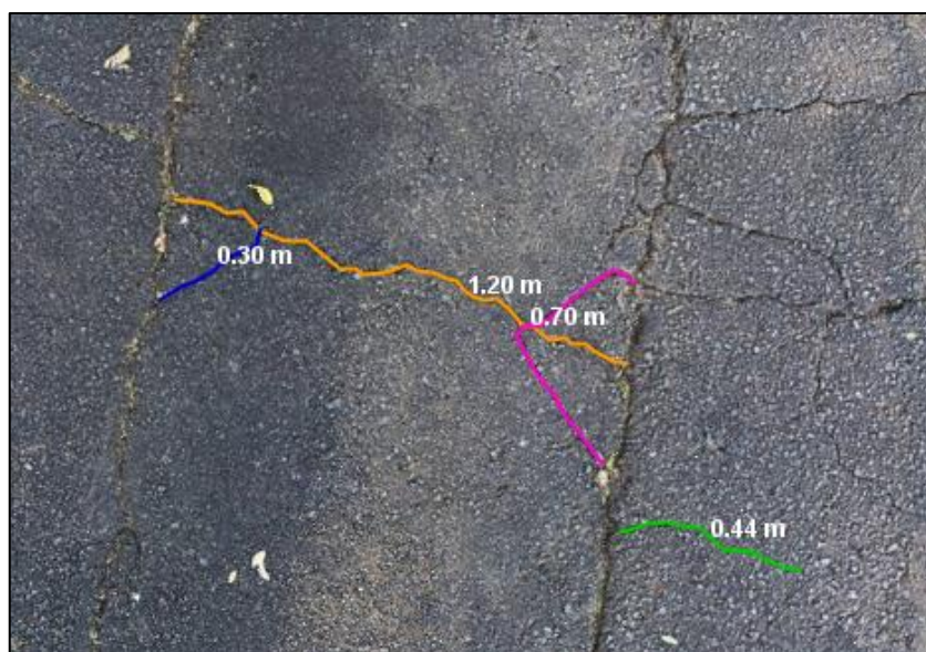
Figura 5.3 – Exemplo de anotação dos defeitos no software iTwin
