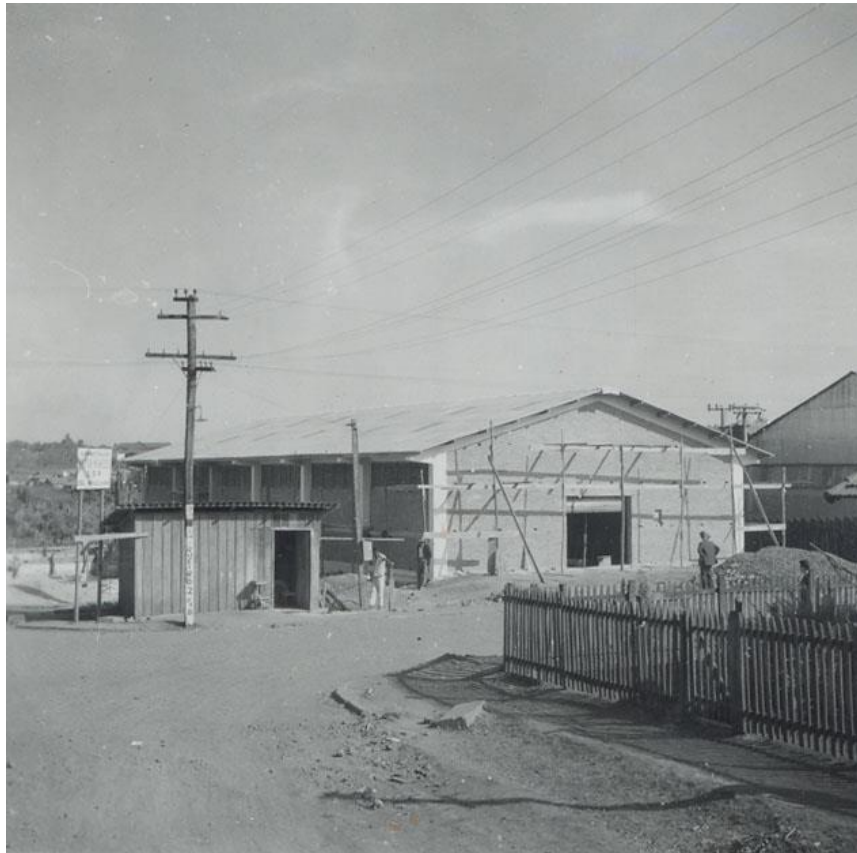
Figura 20 – "Construção do mercado na Vila Casoni"
