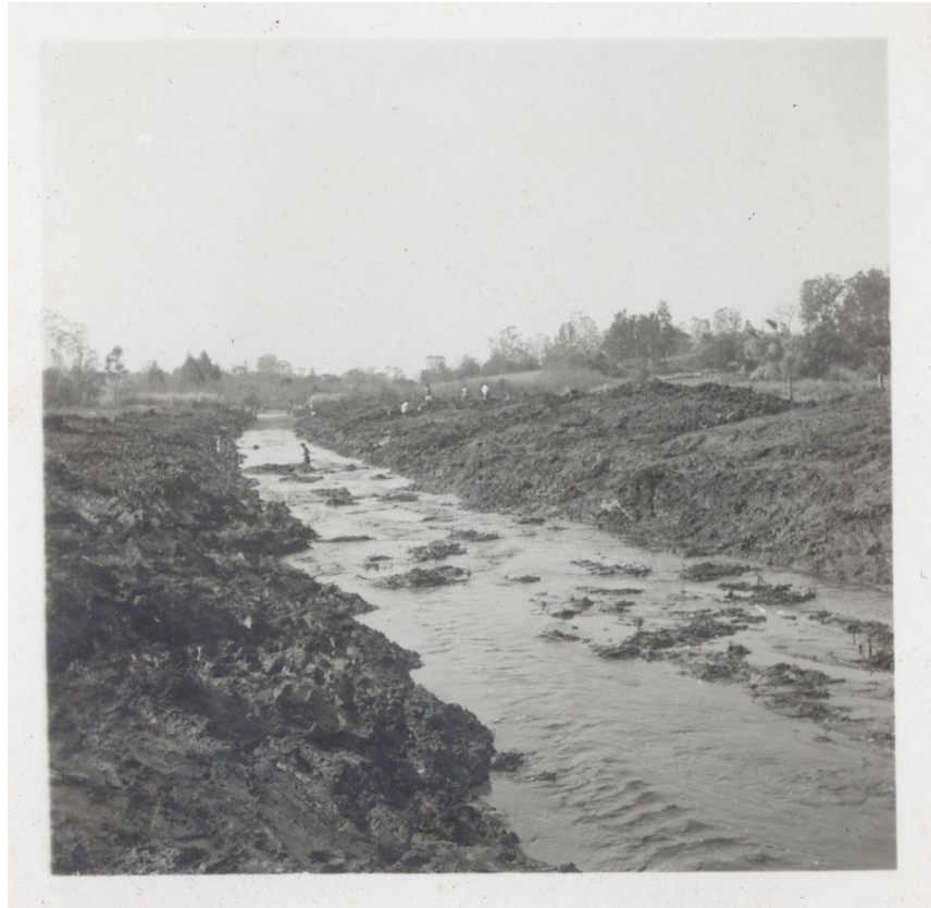
Figura 16 – "Drenagem e alargamento do Ribeirão Quati e Bom Retiro"
