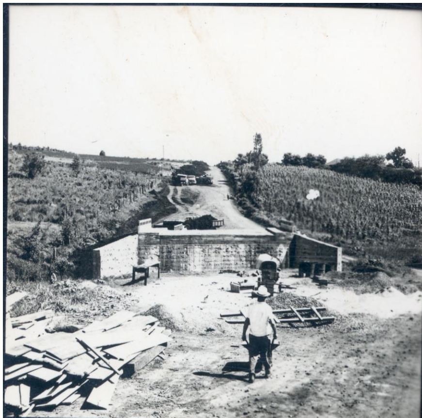
Figura 9 – "Ponte sobre o Ribeirão Quati, ligando a cidade ao Parque Ouro Verde"
