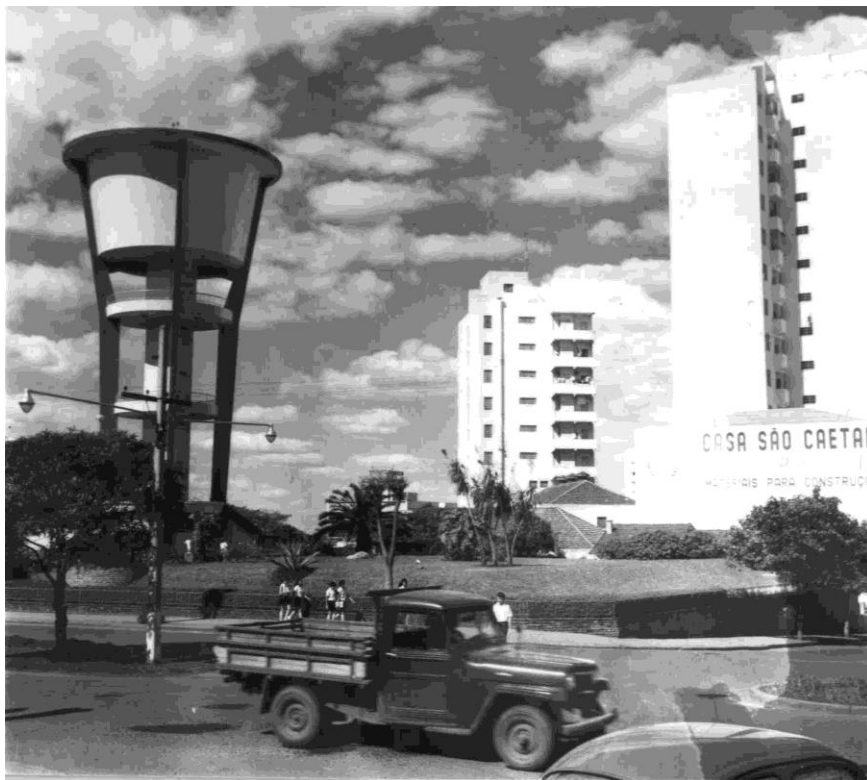
Figura 17: "Caixa D'água localizada na Avenida Higienópolis"
