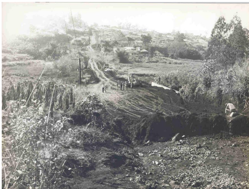
Figura 13 – "Avenida Faria Lima – construção da ponte"
