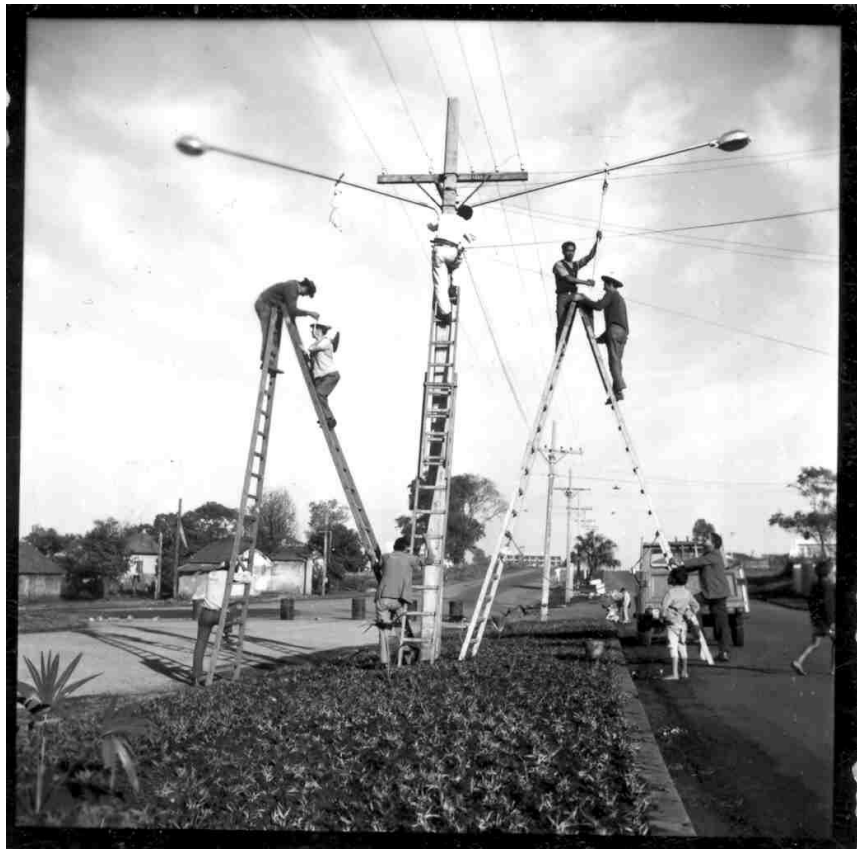
Figura 15 – “Serviço de Iluminação Pública na Avenida Perimetral entre as Ruas Pernambuco e Professor João Cândido”
