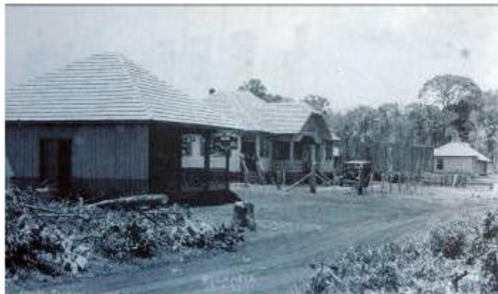
Figura 70 – Avenida Getúlio Vargas: o início de Rolândia. Da esquerda para a direita: padaria do Max Dietz, Hotel Rolândia, Hotel Estrela (em construção) e o escritório da Companhia de Terras Norte do Paraná, em 1937
