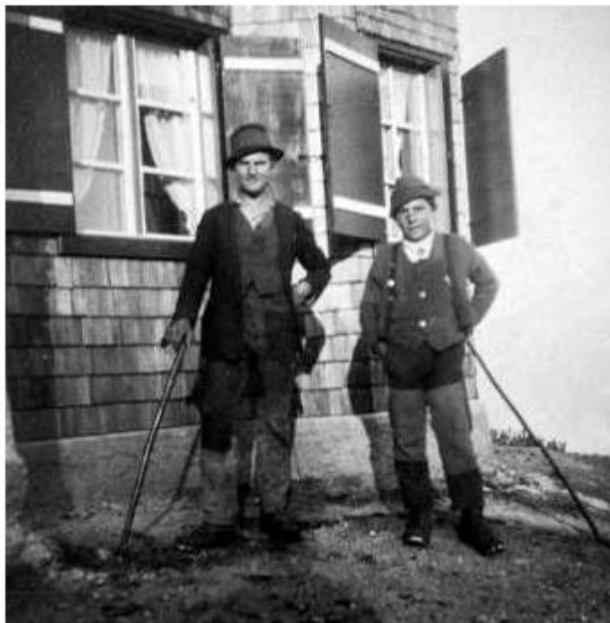
Figura 6 – Hans Kopp, à direita, com o tio, irmão do pai, na Áustria. A parede da casa é revestida com tábuas pequenas. No Brasil, ele usou essa técnica para cobrir sua primeira casa em Rolândia (PR)
