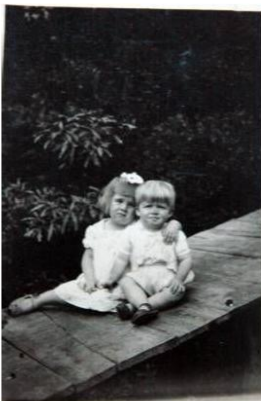
Figura 37 – Anita e Alfonso na rampa de acesso à tulha
