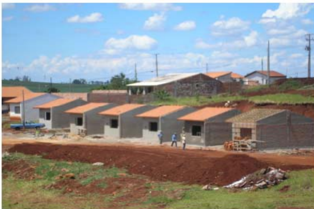
Foto 3 – Vista do Jardim Primavera em nova fase de construção de mais unidades. Verifica-se que as unidades habitacionais são muito pequenas, com área média de 29m 2 , contendo 2 cômodos e o banheiro.
