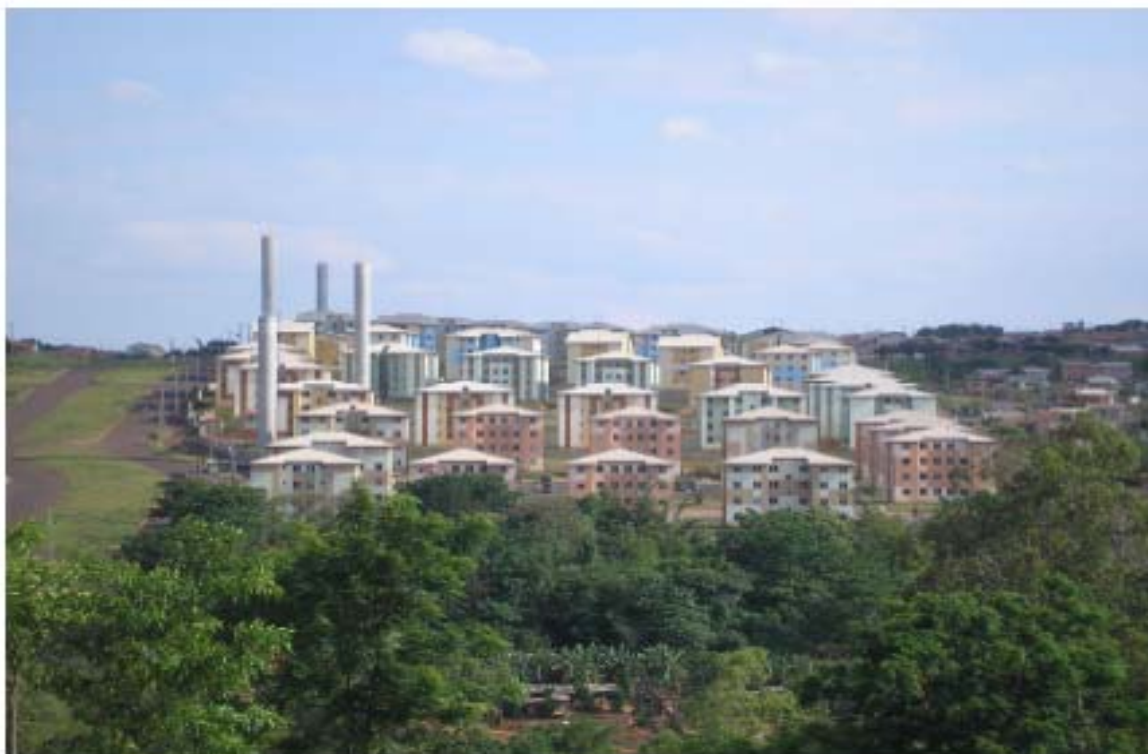
Foto 4 – Vista dos residenciais Anselmo Vedoato, Abel Chimentão e Guilherme Viscardi 60 , construídos através do Programa de Arrendamento Residencial (PAR) pela Cohab-Ld em parceria com a Caixa Econômica Federal.
