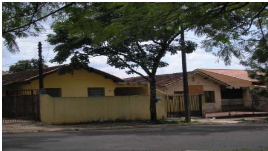
Foto 5 – Unidades habitacionais do Conjunto Habitacional Milton Gavetti, construído em 1978. Ainda é comum a presença de unidades habitacionais que ainda mantêm alguns aspectos de sua forma original, como estas mostradas na foto.
