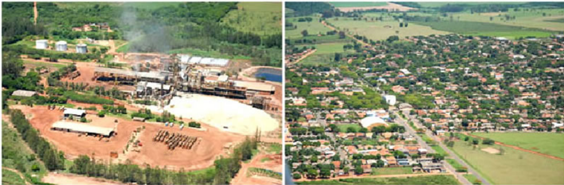
Figura 9 – Vista panorâmica da Unidade de Paracity-PR, USACUCAR
