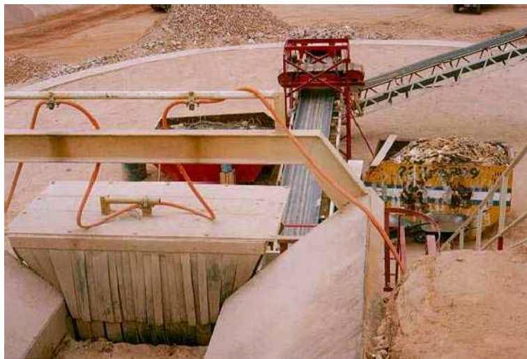
FIGURA 10 – Detalhe do local onde é feita a separação manual de componentes que não são considerados como RCD.
